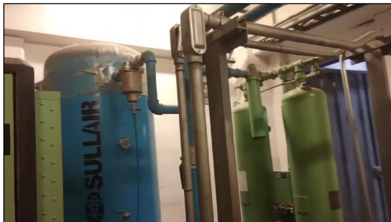
Figura 12. Inspección de instalaciones neumáticas
