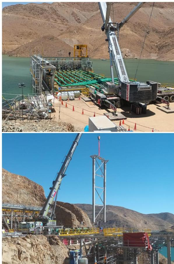
*Figura 34. Proceso de montaje estructuras metálicas*
