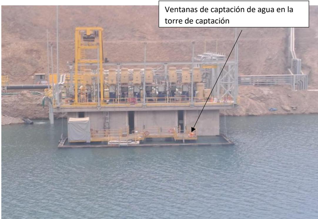
**Figura 12. Sistema de recuperación de agua en operación**
