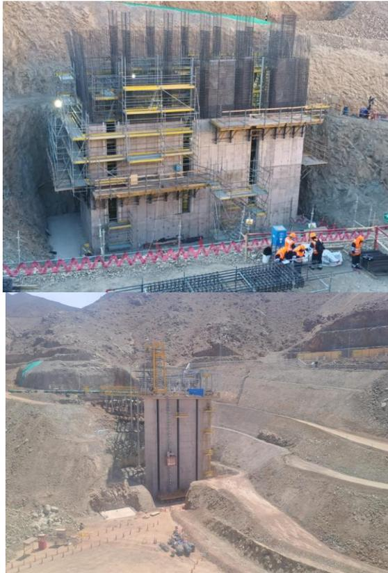
*Figura 33. Proceso de construcción de torre de captación*
