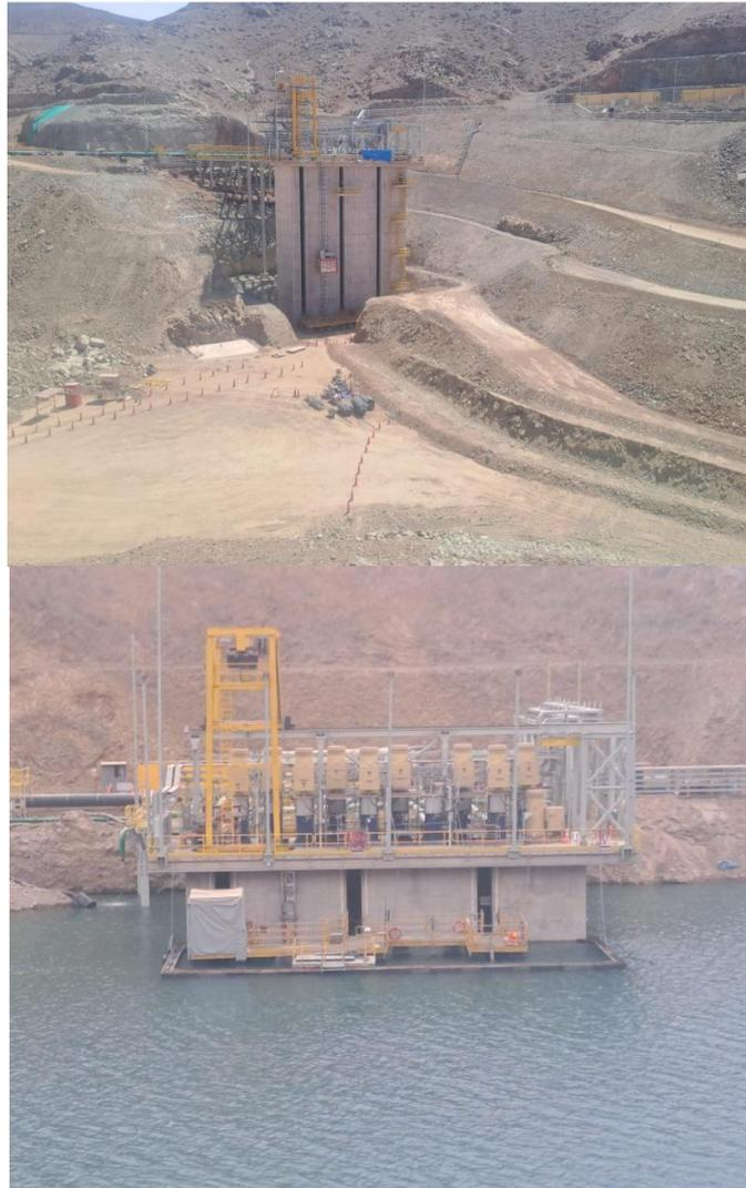
*Figura 16. torre de captación y bombas verticales*
