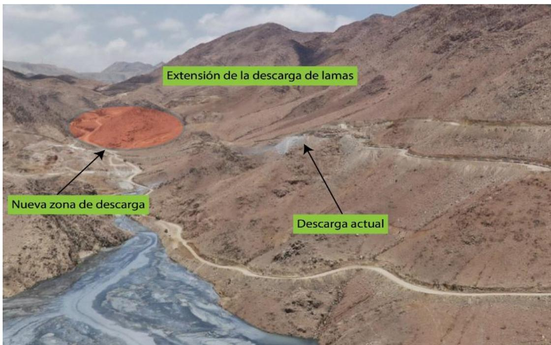
*Figura 9. Proyecto de construcción extensión descarga de tubería lama sur*
