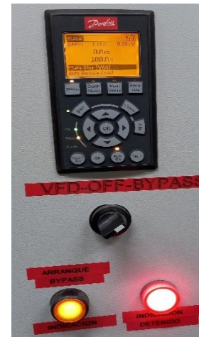
Fig. 7. Foto del variador de frecuencia de uno de los agitadores funcionando
