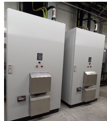
Fig. 6. Foto de paneles con variadores de frecuencia y arrancadores redundante
