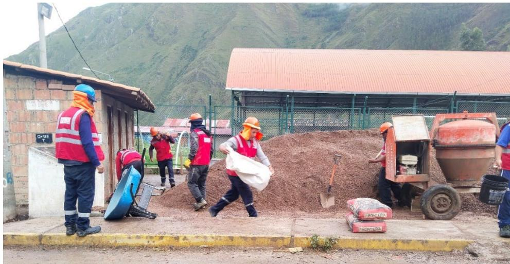
**Trabajos de vaciado y vibrado del concreto  $f_c= 175 \text{ kg/cm}^2$ , de muro y base del canal de riego del sector de Tanccac**
