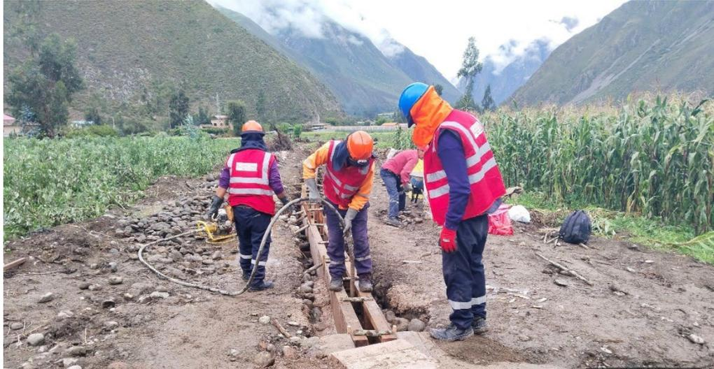
**Trabajos del vaciado del canal de derivacion con concreto  $f_c= 175 \text{ kg/cm}^2$  de muro y base del canal de riego**
