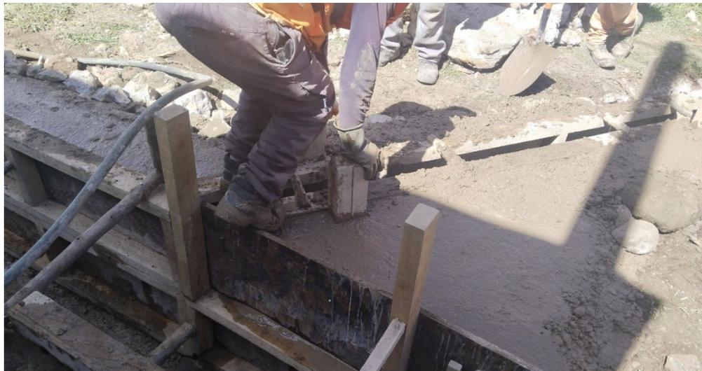
**Trabajos del vaciado del canal de derivacion con concreto  $f_c = 175 \text{ kg/cm}^2$
