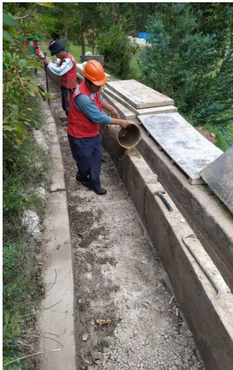
**Tramo del canal de riego vaciado desencofrado**
