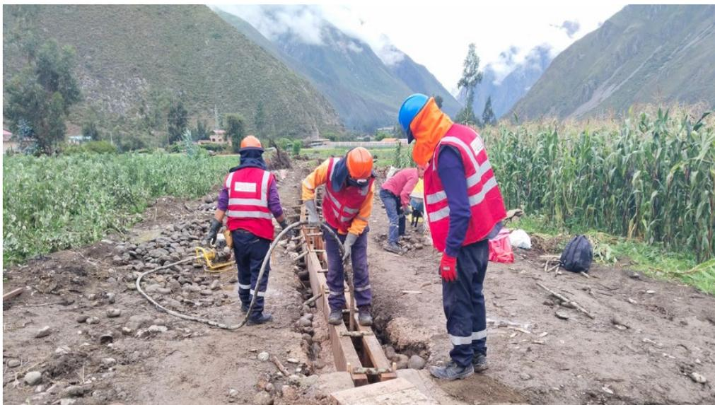
*Figura 13. Verificación del vibrado del concreto.*
