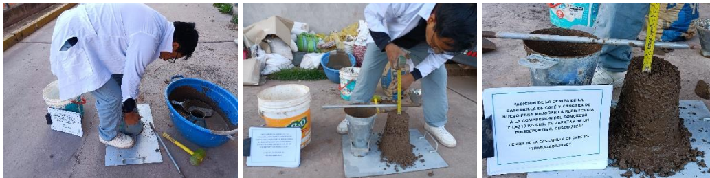
Ensayo de asentamiento
