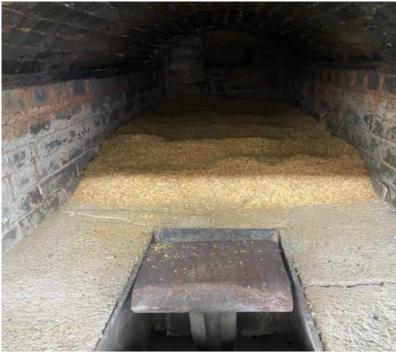
Figura 2 Horno de incineración de la cascarilla de café
