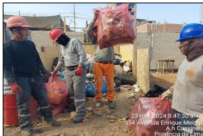
Figura 20: Segregación de residuos peligrosos y no peligrosos.
