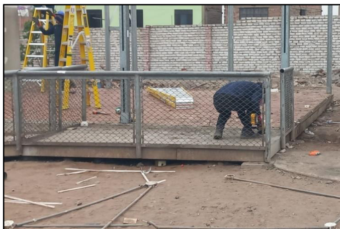
Figura 7: Desmontaje de estructuras existentes
