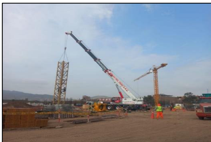
Figura 11: Montaje de torre grúa 2
