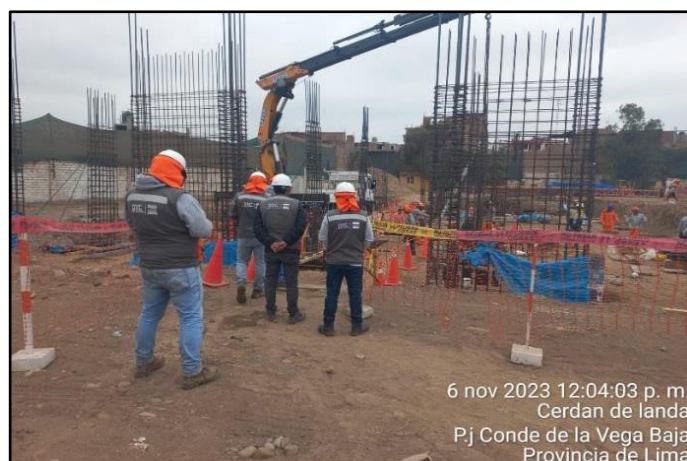
Figura 15: Izaje y colocación de acero dimensionado
