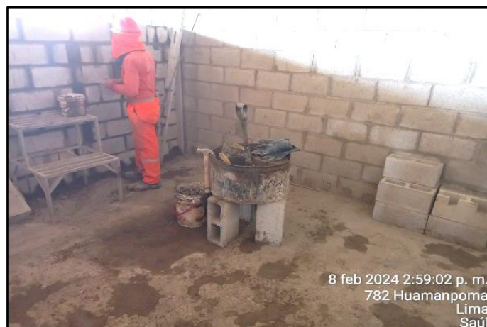
Figura 26: Asentado de ladrillo calcáreo
