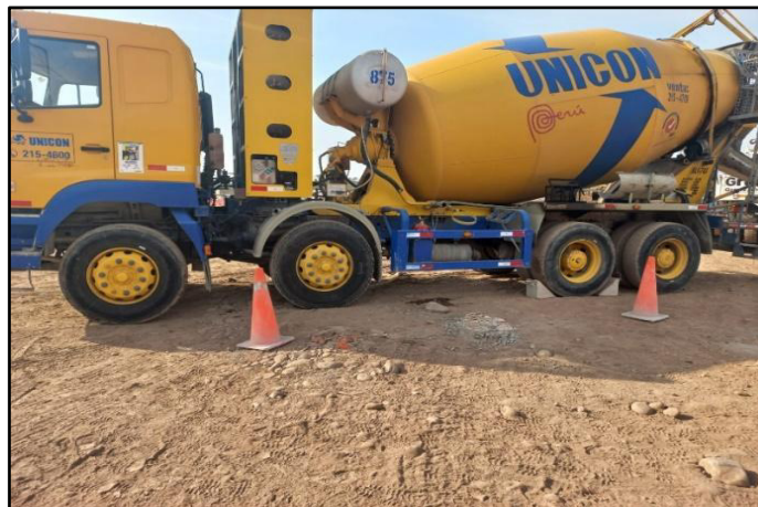
Figura 29: Vaciado con mixer y bomba de concreto
