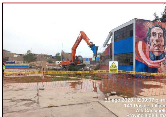
Figura 5: Demolición de estructuras con excavadora sobre oruga
