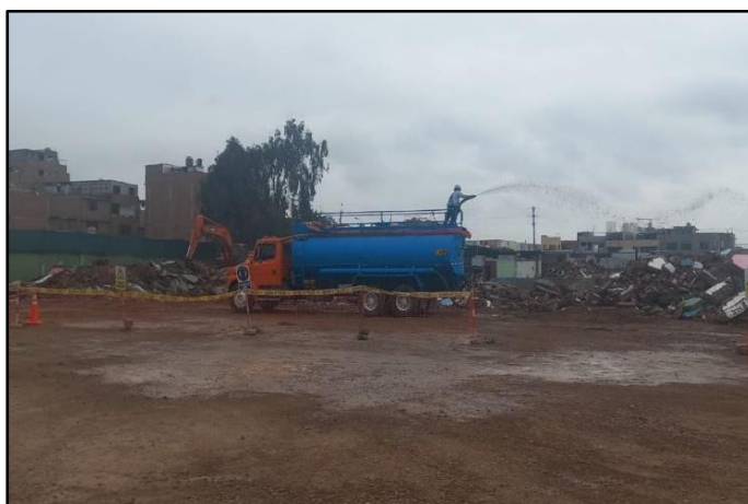
Figura 8: Control de polución durante la demolición
