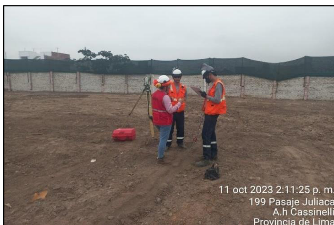
Figura 9: Trazo y replanteo topográfico
