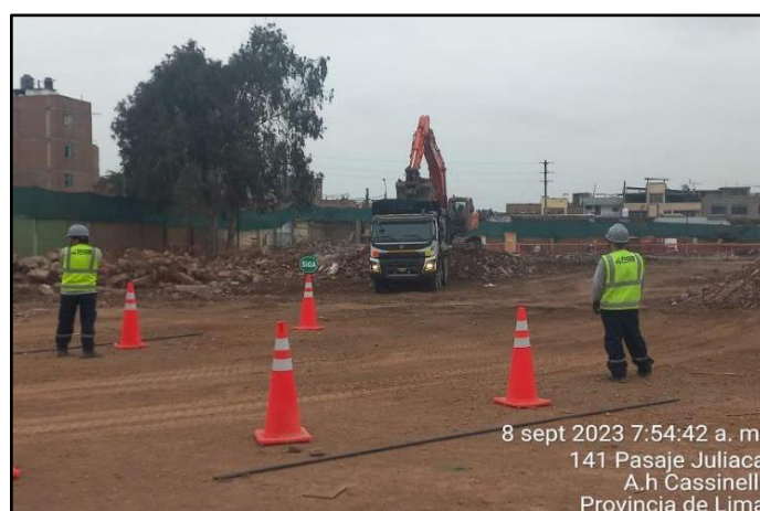
Figura 6: Eliminación de material producto de la demolición
