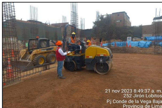
Figura 16: Compactación de terreno
