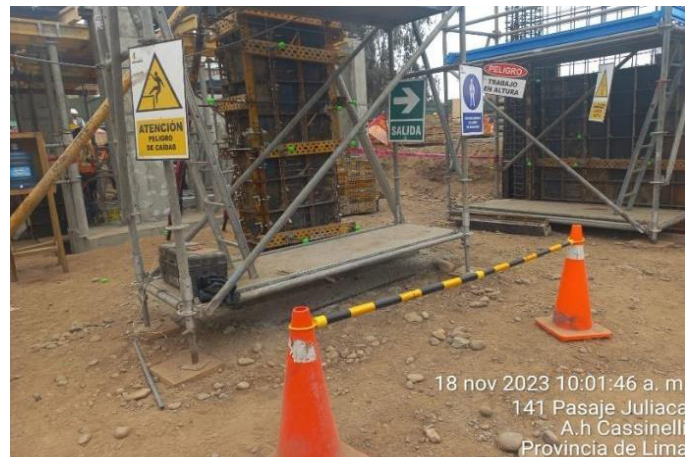
Figura 19: Encofrado de elementos verticales y horizontales
