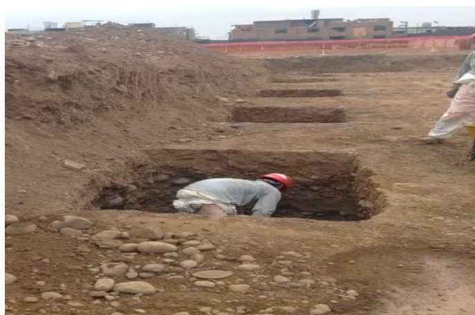
Figura 14: Perfilado manual de excavaciones
