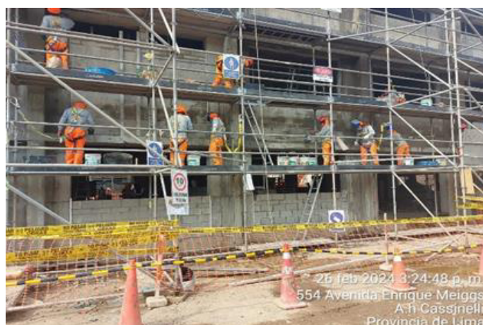
Figura 24: Tarrajeo de fachada
