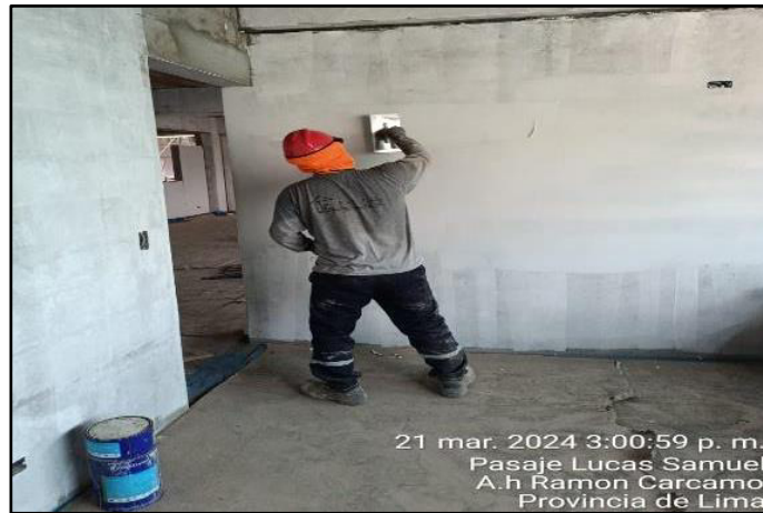
Figura 28: Empastado y pintado de interiores y exteriores
