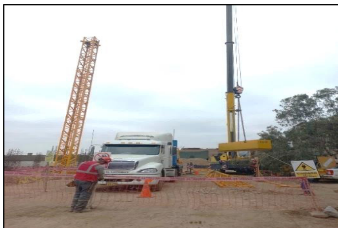
Figura 10: Montaje de torre grúa 1
