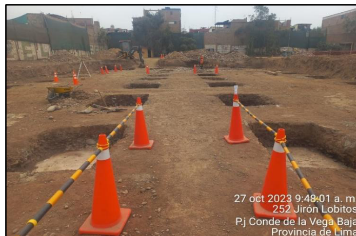
Figura 13: Excavación y habilitación de terreno para zapatas
