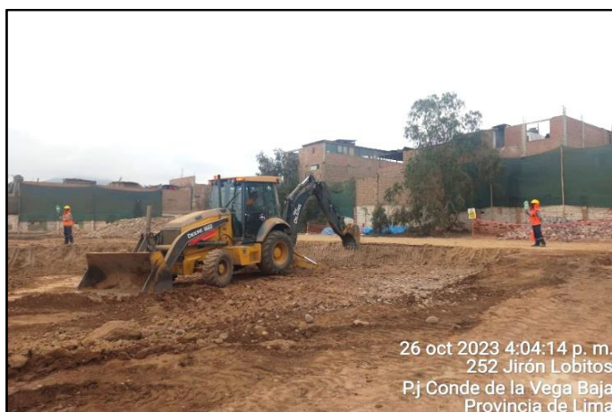
Figura 12: Excavación de terreno con retro excavadora
