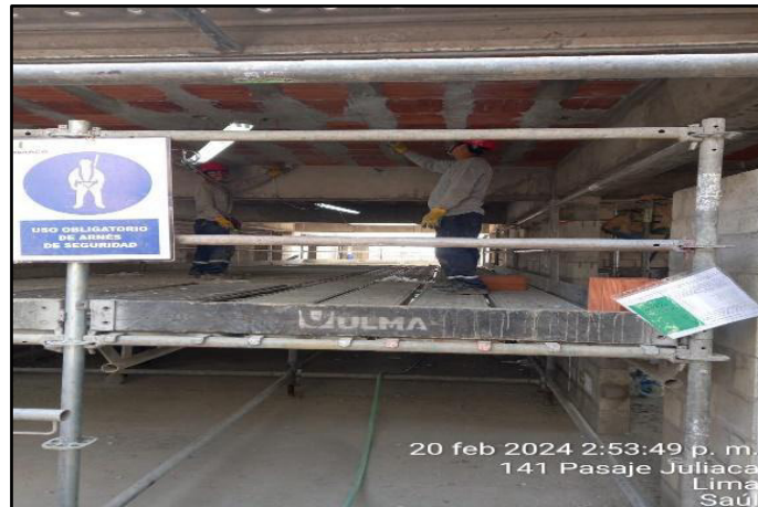
Figura 25: Tarrajeo de interiores
