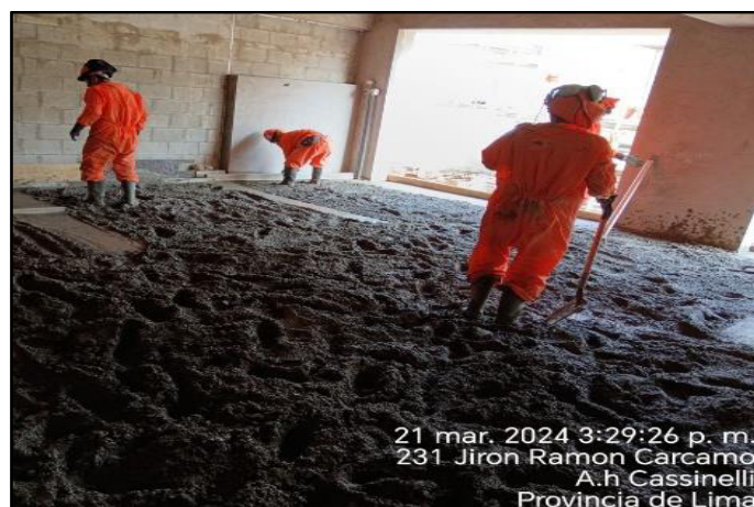
Figura 27: Vaciado de contrapiso
