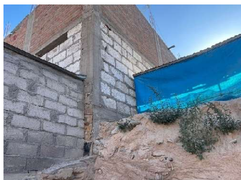
Figura 2. Deterioro de bloques de concreto.
