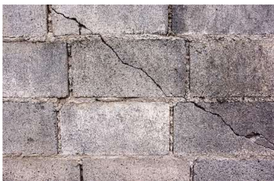
Figura 1. Grieta en muro de bloque de concreto.
