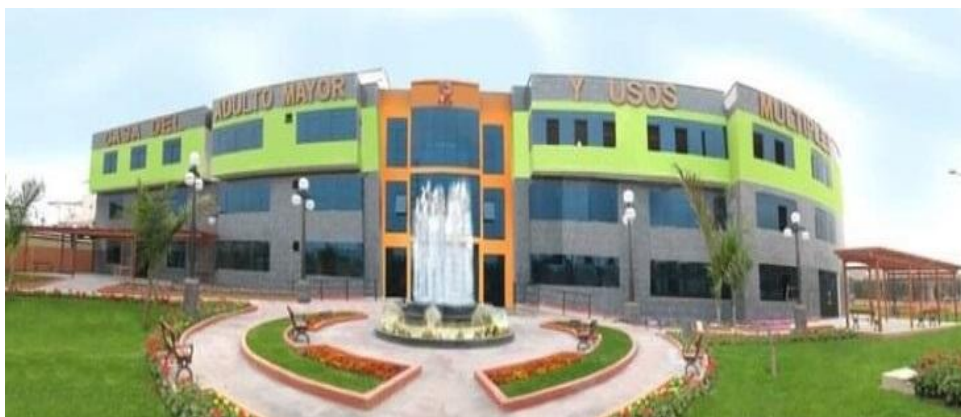
Figura 4: Vista panorámica de Casa del Adulto Mayor en Chorrillos – Lima
