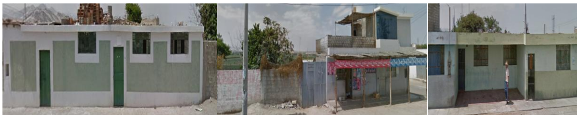
Vista Panorámica – Altura de edificaciones: Calle Cerrito 03
