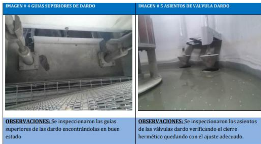
Figura 10. Guías superiores de dardo y asientos de válvulas
