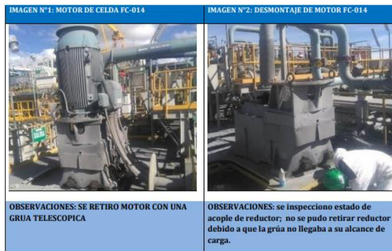
Figura 4. Observaciones de motor y desmontaje de motor de la celda FC-014
