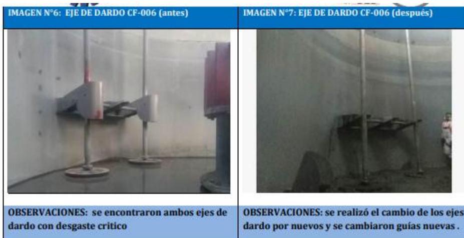
Figura 15. Eje de dardo antes y después de su instalación en la celda CF-006
