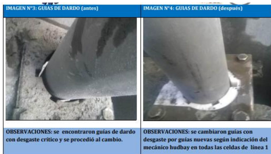
Figura 13. Guía dardo antes y después de su instalación
