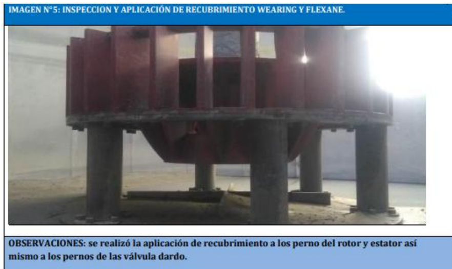
Figura 14. Inspección y aplicación de recubrimiento wearing y flexane
