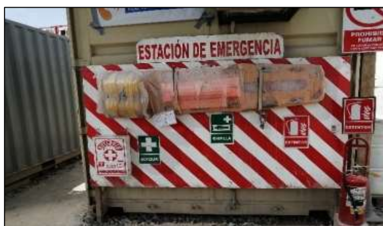
Figura 18. Estaciones de emergencia en concentradora 1
