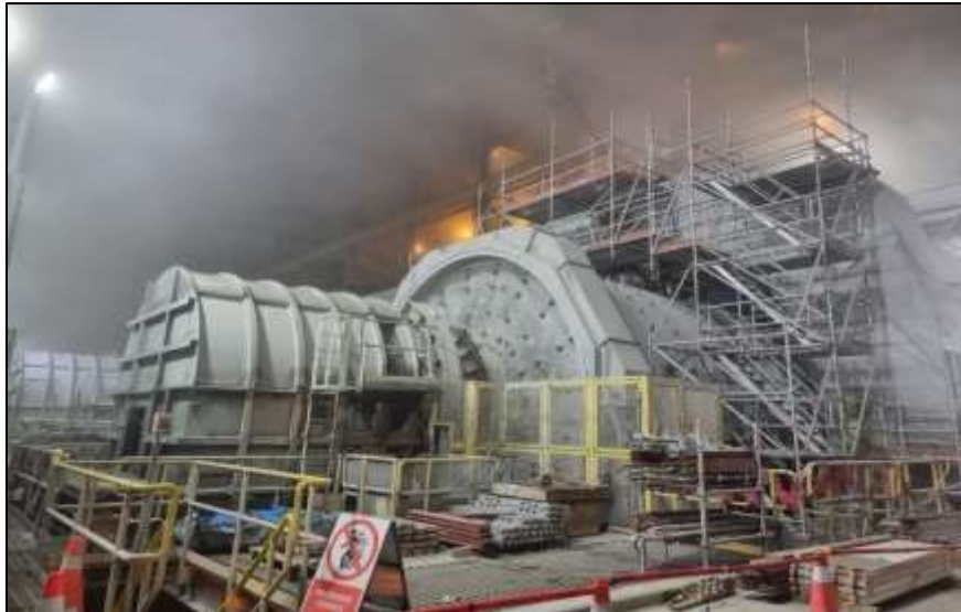
Figura 22. Señalización en el área de trabajo.
