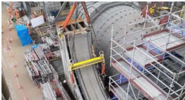
Figura 3. Molino de bolas N° 04 en planta concentradora N° 1.
