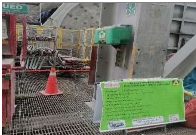
Figura 38. Cartel de control crítico.
