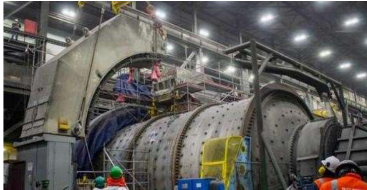
Figura 1. Estator de molino de bolas SAG – Antamina.
