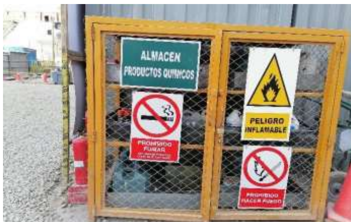
Figura 21. Señalización implementada el proyecto
