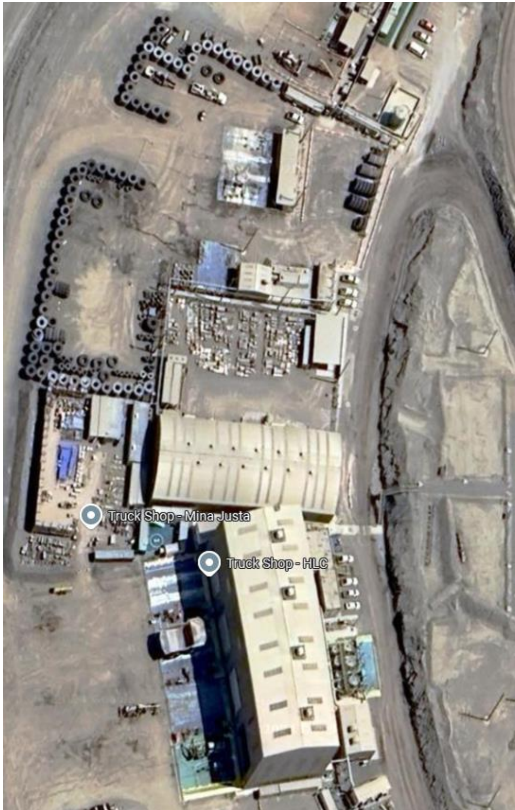
Figura 4. Instalaciones de Logística Almacenes (Truck Shop).
