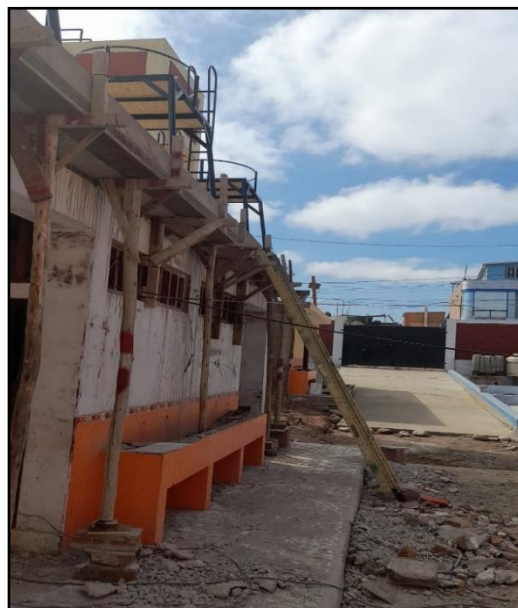
Encofrado de la estructura y vaciado de losa aligerada de cocina
