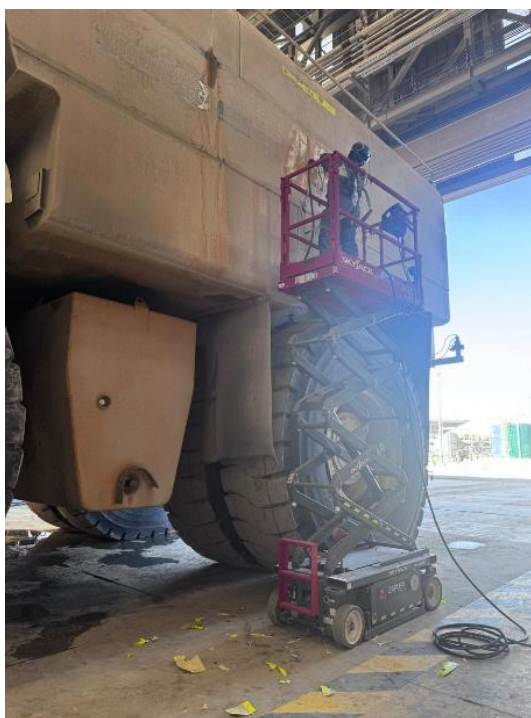
Figura 3. Imagen referencial de aplicación de pintura fotoluminiscente.
