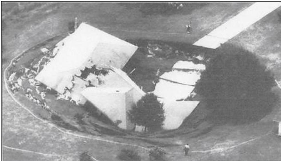
**Figura 4.** Colapso del terreno y hundimiento de viviendas existentes. Tomado de “Suelos colapsables: conceptos y desarrollo de patologías” por ASEFA seguros, 2009, p. 5.
