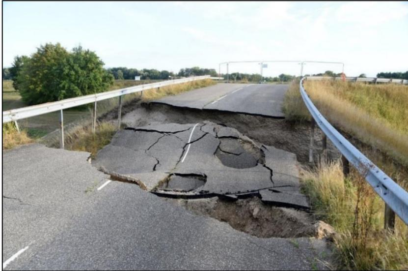
**Figura 3.** Deformación en vías a consecuencia de un colapso de suelo, tomado de “vía colapsa a la salida de Fort-Louis”, por Antoine Cazabonne,2020.
