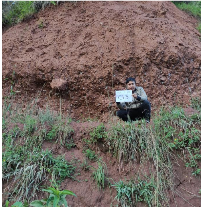
Ubicación de la progresiva 11 +180, donde se ubica el corte 3. En las coordenadas UTM 8514077, 649803.
