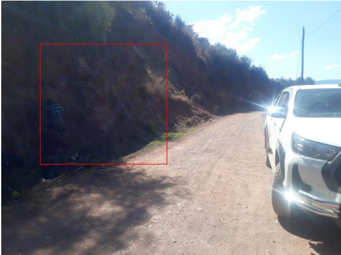
Realización de calicatas para el corte 1-1, la prueba se realizó al lado de la carretera existente.
