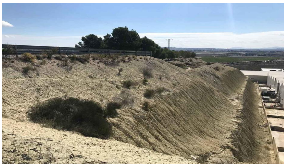
Figura 2. Talud Estabilizado Recubierto de Vegetación. Tomada de “Aplicación de geomallas para el refuerzo de taludes”, por TexDelta, 2022.
