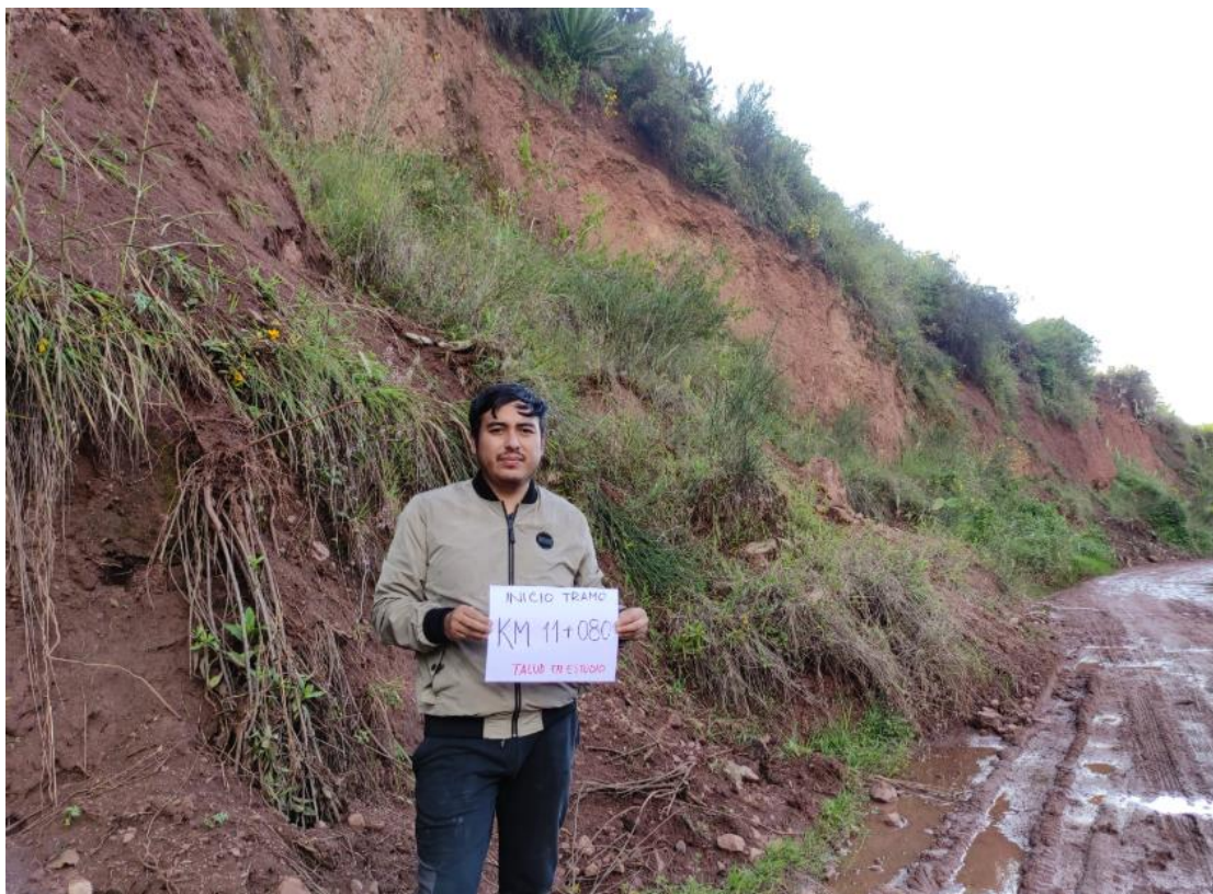
Ubicación de la progresiva KM 11+080, tramo inicial. En las coordenadas UTM 8514011.2620 649883.4542
