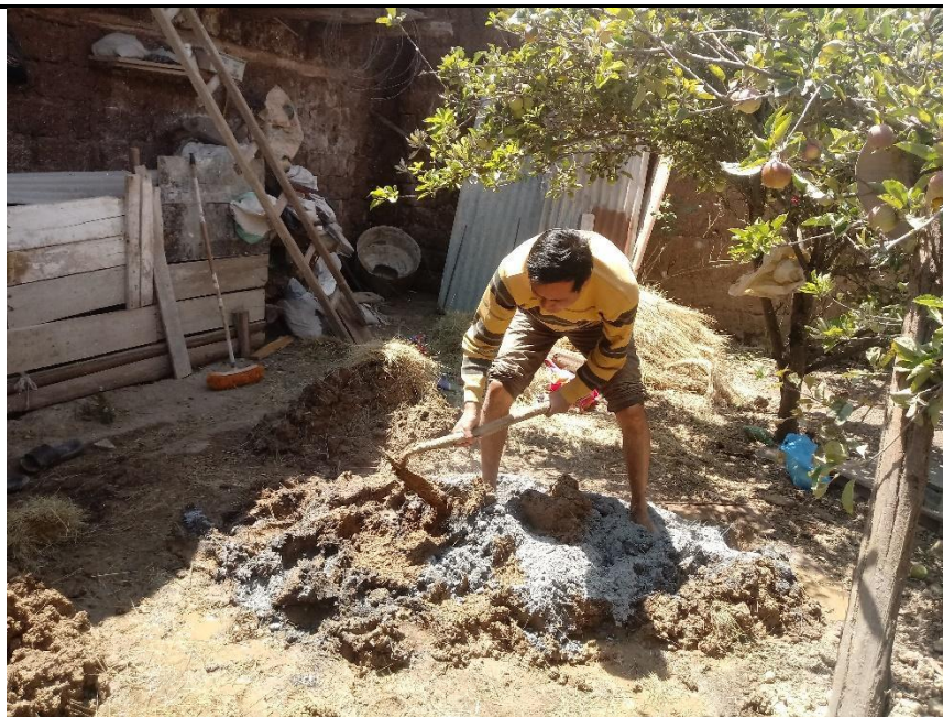
Foto N° 10. Mezclado de barro, paja ichu y ceniza de residuo de tarwi para la elaboración de adobes
