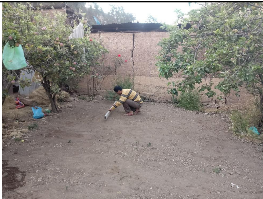
Foto N° 11. Aplanamiento (regleado) de superficie para colocado (puesta) de adobes
