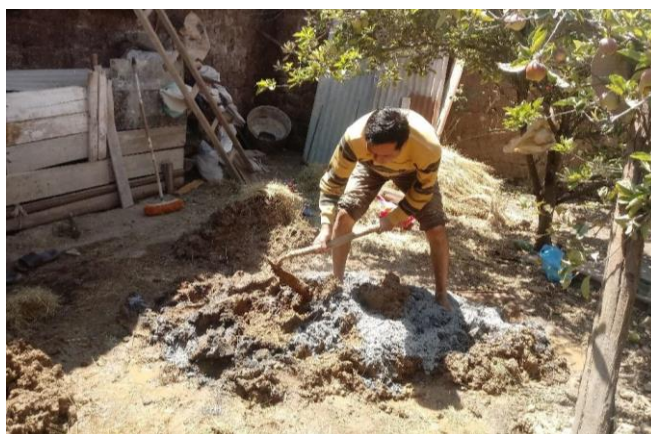
Figura 26. Preparación de mezcla con adición de ceniza
