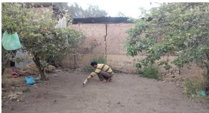
Figura 25. Habilitación de área para la elaboración del adobe
