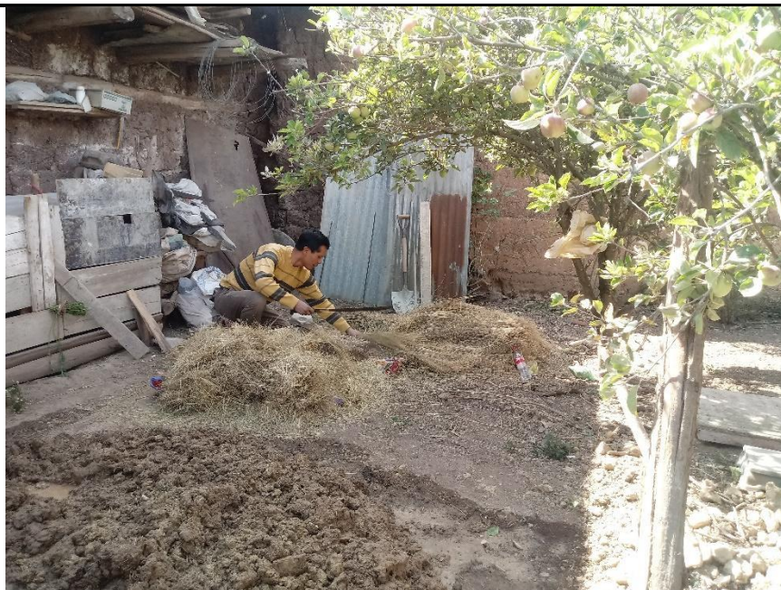
Foto N° 08. Corte o picado de paja ichu, L=0.20m (aproximado)
