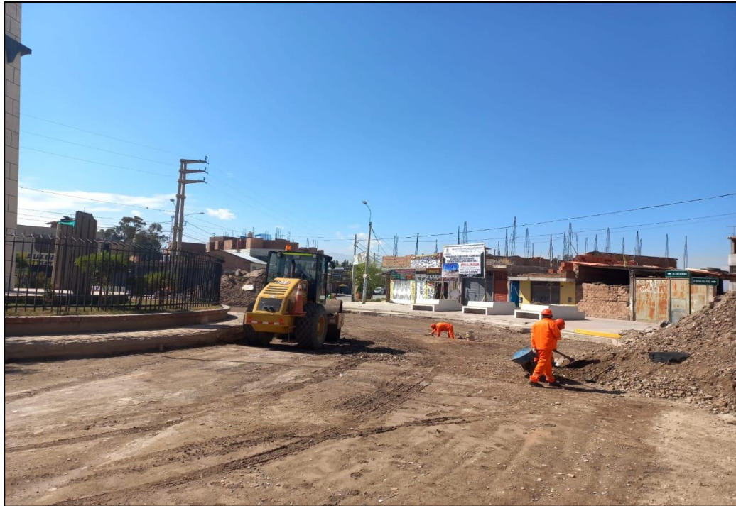
Figura 23. Compactación con maquinaria
