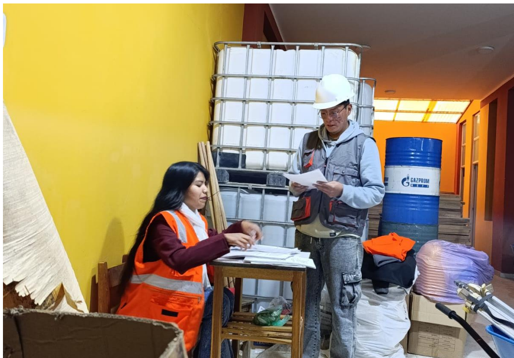
Figura 21. Inspección al Área de almacén de Obra
