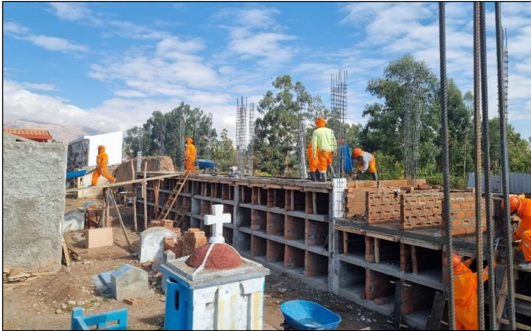
Figura 39. Vista general del trabajo
