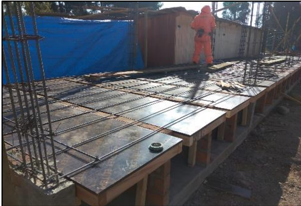
Figura 37. Encofrado de losa maciza
