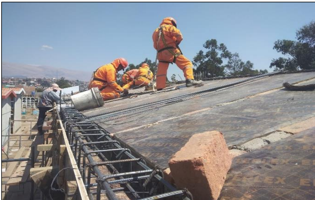
Figura 40. Acero de refuerzo grado 60 F_y=4200 \text{ kg/cm}^2
