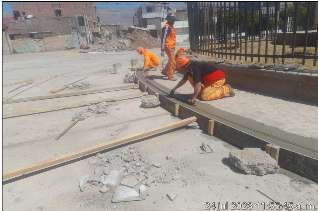
Figura 25. Encofrado de losa de concreto f'c=210\text{kg/cm}^2
