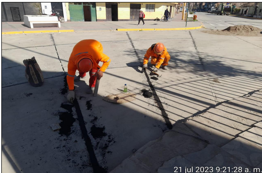
Figura 28. Colocación de junta asfáltica Nota: se rellenaron las juntas con mezcla de asfalto liquido RC-250 con arena fina para contrarrestar los cambios de temperatura en el concreto (dilatación térmica).
