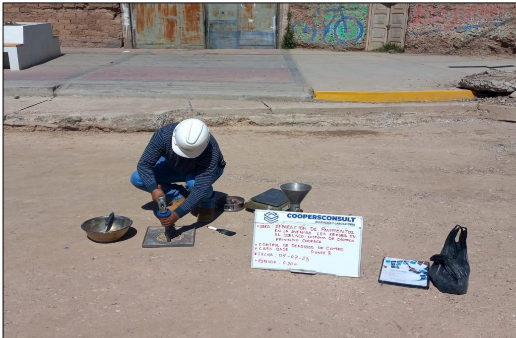
Figura 24. Verificación del ensayo de densidad de campo
