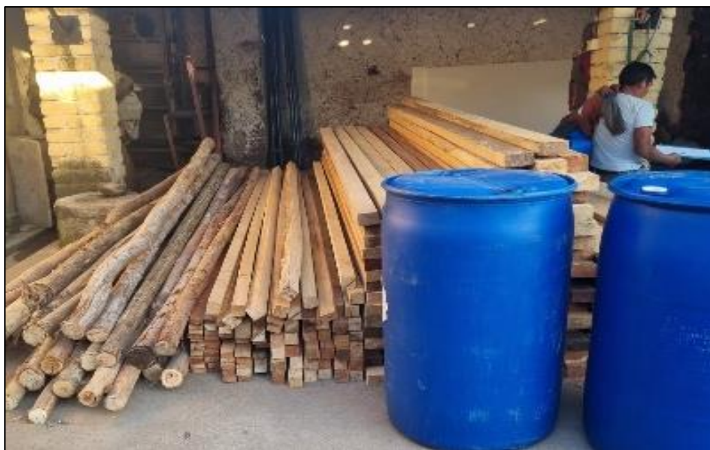
Figura 31. Inspección al área de almacén de obra
