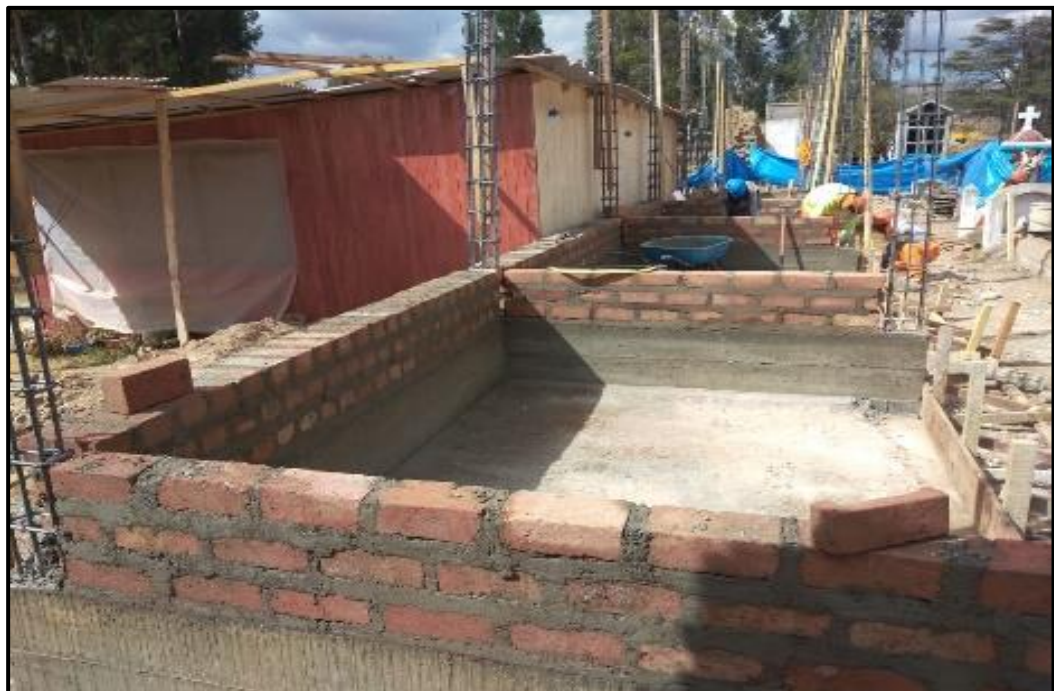
Figura 36. Muros de ladrillo de cabeza y de canto, mezcla C: A 1:5 para tarrajeo
