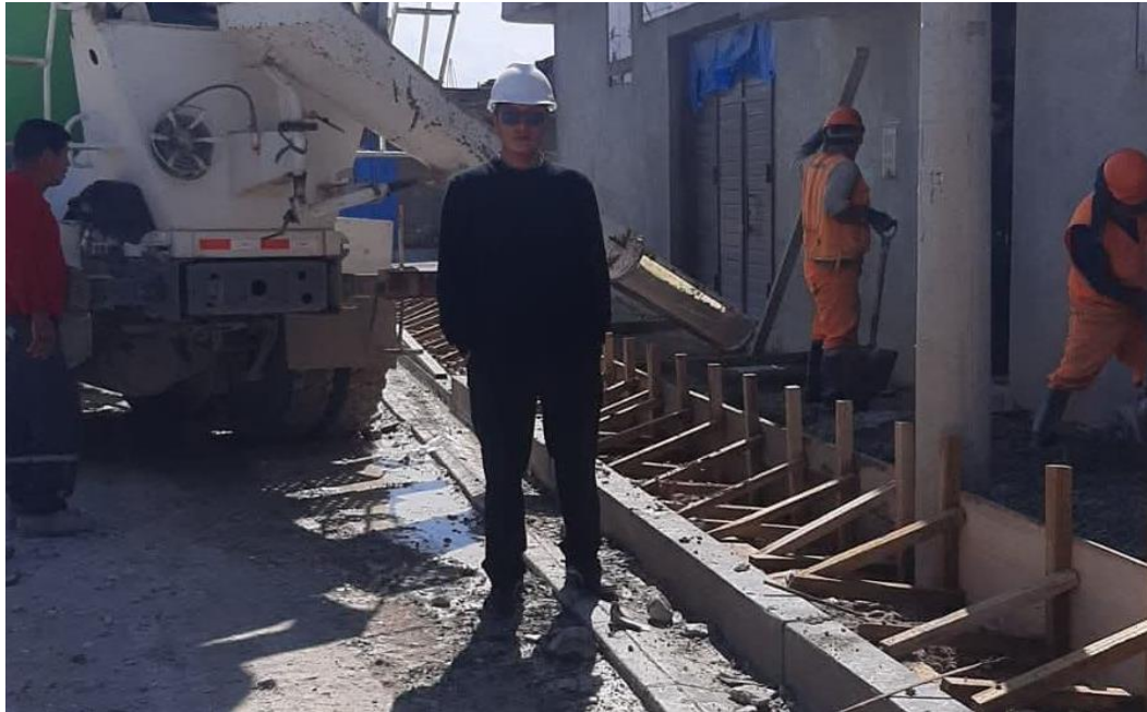
Figura 19. Inspección inopinada a obra
