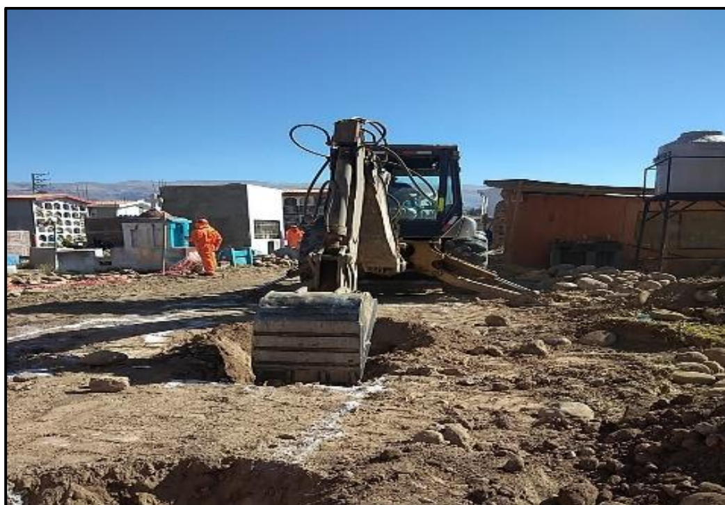
Figura 34. Excavación de zanjas en terreno normal
