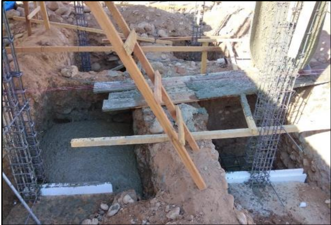
Figura 35. Vaciado de concreto f'c=210 \text{ kg/cm}^2 en zapatas
