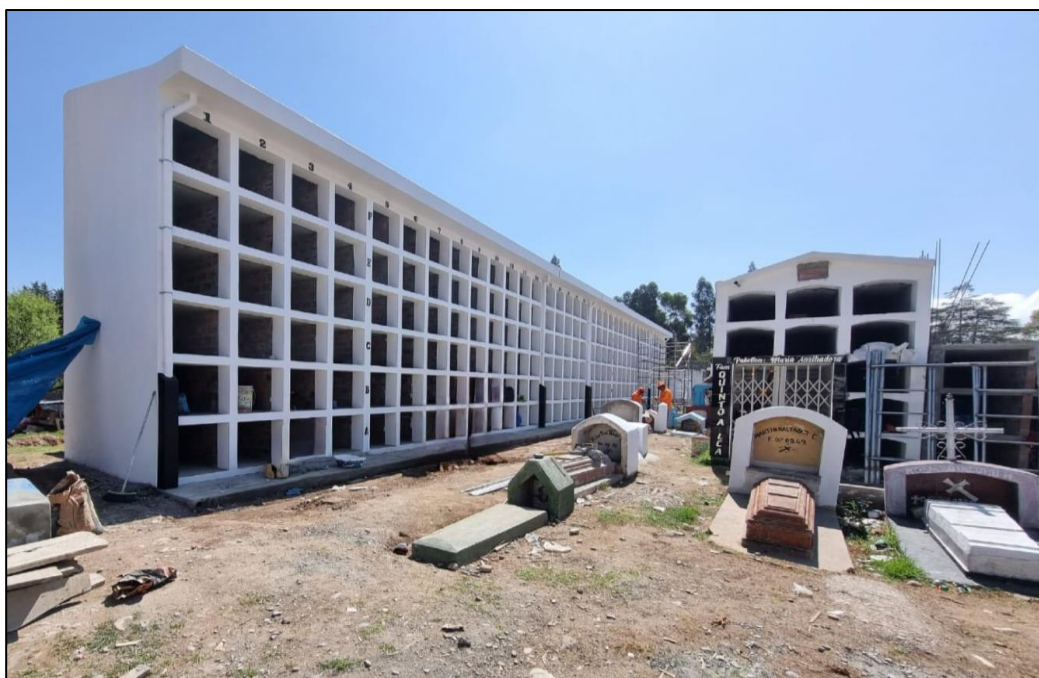
Figura 41. Pintura en elementos estructurales y finalización de obra
