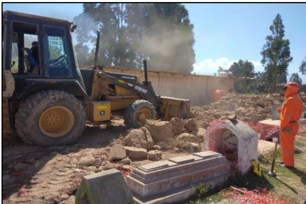
Figura 33. Eliminación de material excedente con maquinaria
