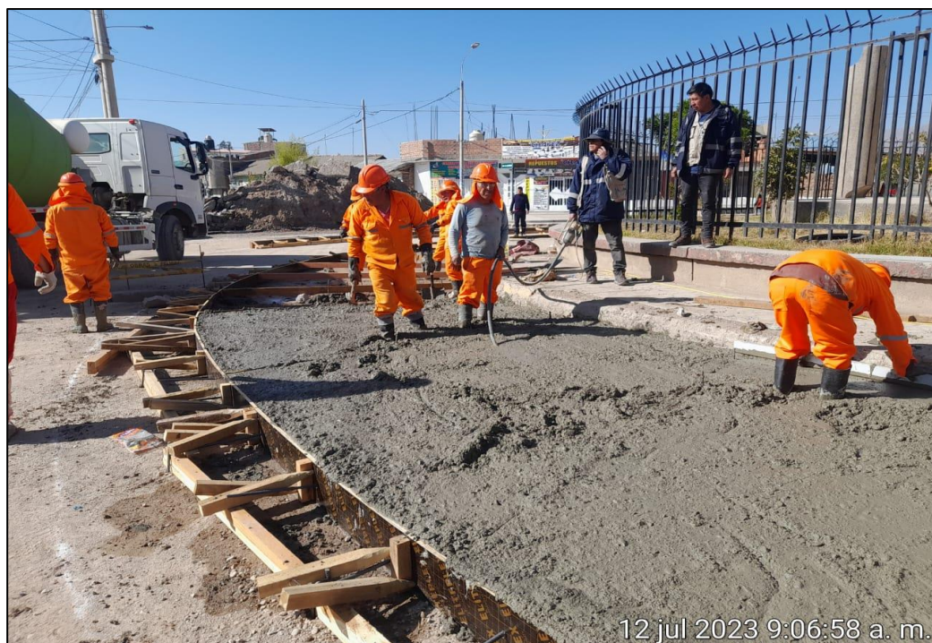
Figura 27. Inspección del proceso constructivo en el vaciado de concreto f'c=210 kg/cm 2 Nota: se realizó el vaciado de concreto pre-mezclado f'c=210 kg/cm 2 , también se logra observar el proceso de vibrado con equipo cumpliendo con los procesos constructivos.
