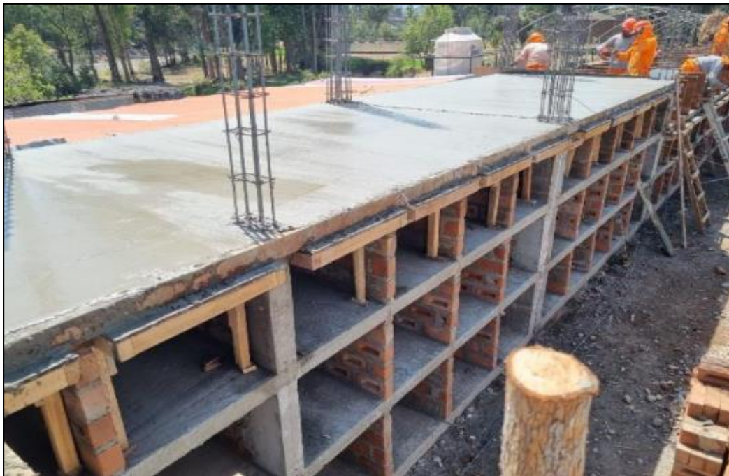
Figura 38. Vaciado de concreto F'c=210 \text{ kg/cm}^2 en losa maciza
