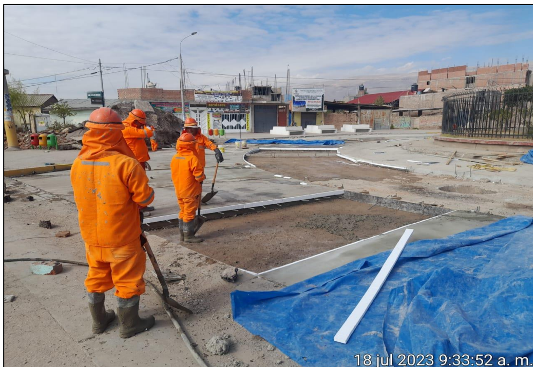
Figura 26. Pavimento rígido y acero en juntas de contracción
