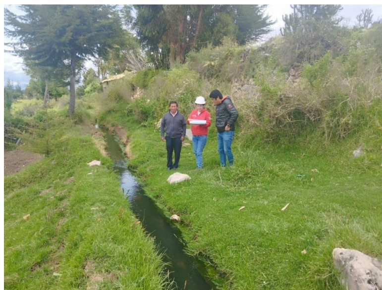
FOTOGRAFÍA N°07: En el proyecto “Mejoramiento Del Servicio De Provisión De Agua Para Riego En El Canal De Riego Del Tercer Cuartel, De Centro Poblado Concho Distrito De Tunan Marca De La Provincia De Jauja Del Departamento De Junín”, Se realizo la verificación de las metas planteadas por el consultor en el canal de Riego del tercer cuartel.
