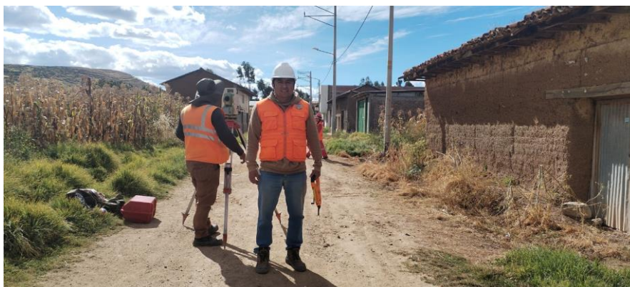
FOTOGRAFÍA N°09: En el proyecto “Mejoramiento Del Servicio De Agua Potable Rural Y Mejoramiento Del Servicio De Alcantarillado U Otras Formas De Disposición Sanitaria De Excretas En La Localidad De Santa Cruz De Vilca Distrito De Aco De La Provincia De Concepción Del Departamento De Junín”, Que a través del convenio de unidad formuladora entre la municipalidad Distrital de Tunan Marca y Municipalidad Distrital de Aco ,Se realizo el acompañamiento en el proceso de levantamiento topográfico, verificando los datos previos a la elaboración de la ficha.
