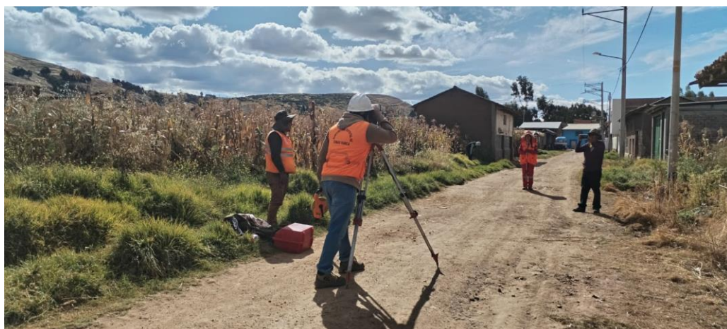
FOTOGRAFÍA N°10: En el proyecto “Mejoramiento Del Servicio De Agua Potable Rural Y Mejoramiento Del Servicio De Alcantarillado U Otras Formas De Disposición Sanitaria De Excretas En La Localidad De Santa Cruz De Vilca Distrito De Aco De La Provincia De Concepción Del Departamento De Junín”, Que a través del convenio de unidad formuladora entre la municipalidad Distrital de Tunan Marca y Municipalidad Distrital de Aco, Se realizo la verificación de los datos propuesto en la ficha.
