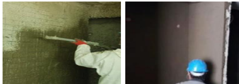
Proyectado de mortero y tarrajeo final
