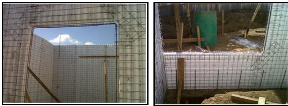
Colocación de refuerzos de U.
