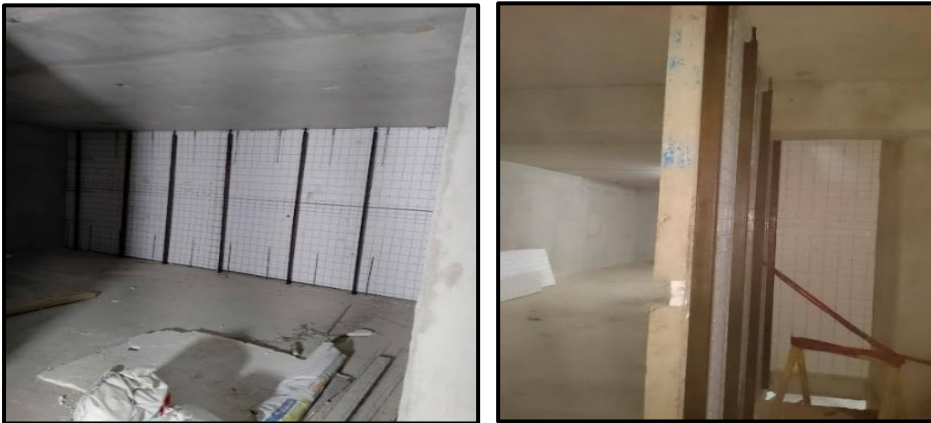
nivelación de paneles verticales
