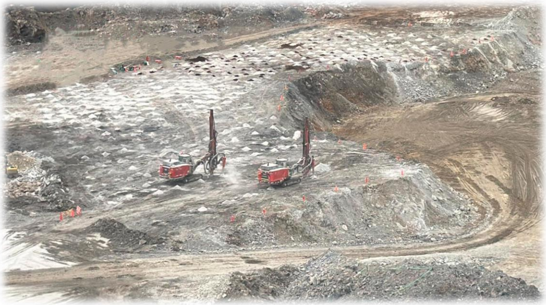
Anexo n° 15: Imagen proceso de perforación en plataforma
