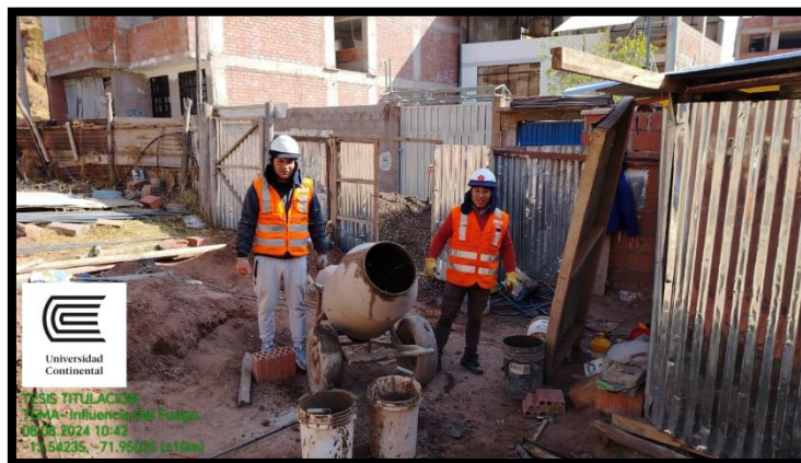
Figura 12. Preparado de concreto f'c=210 kg/cm 2 .
