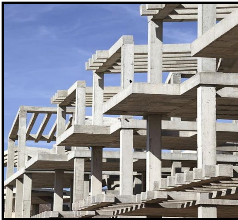
Figura 1. Vigas y columnas de concreto
