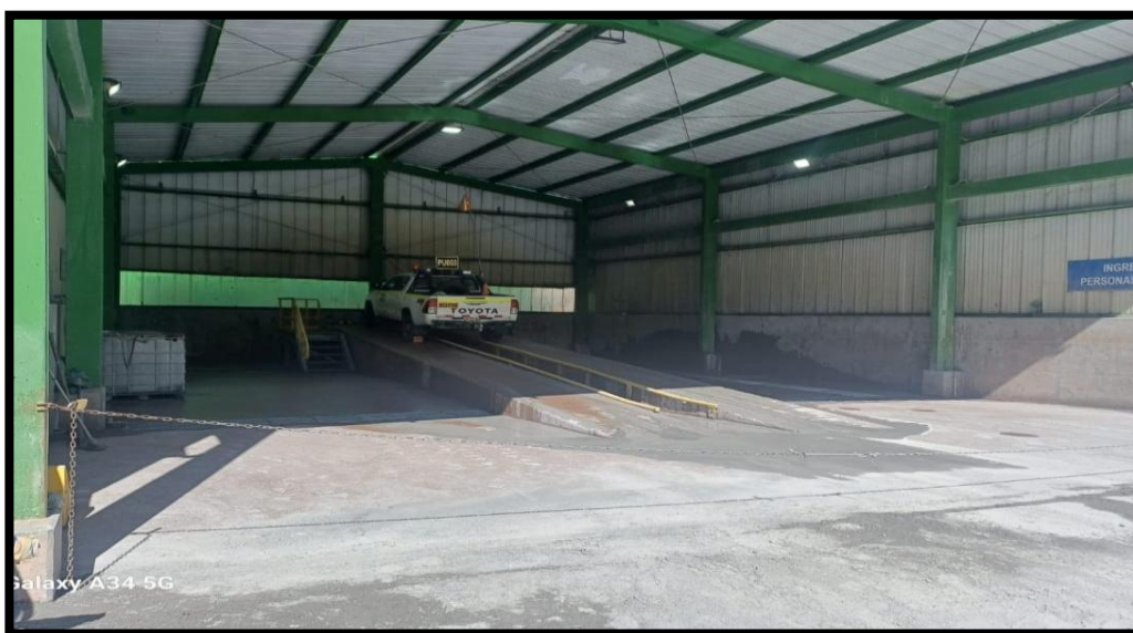
Figura 51. Área de lavado de equipos sucia.
