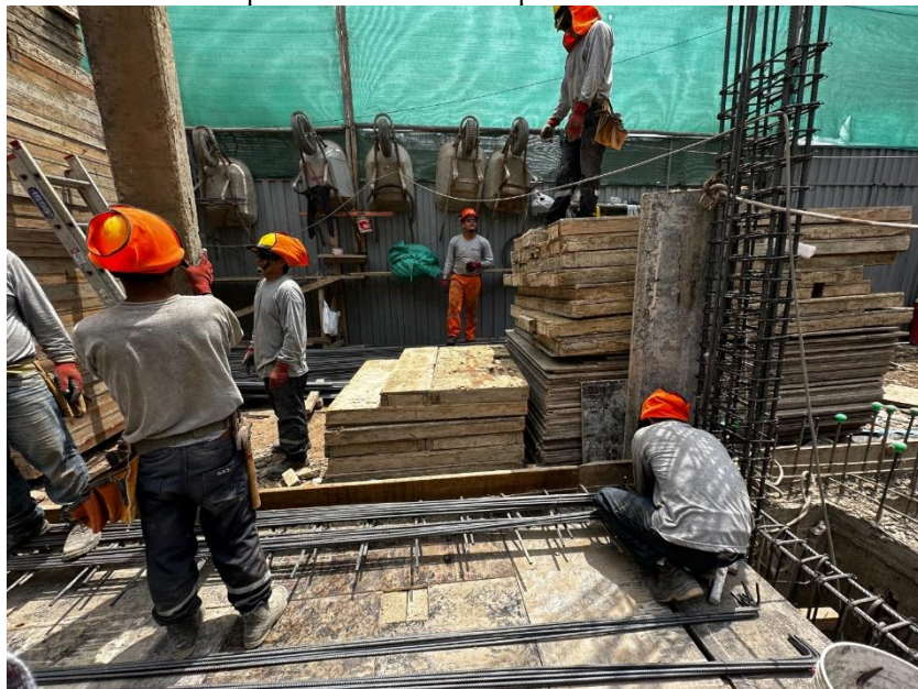
Preparación de materiales para el encofrado
