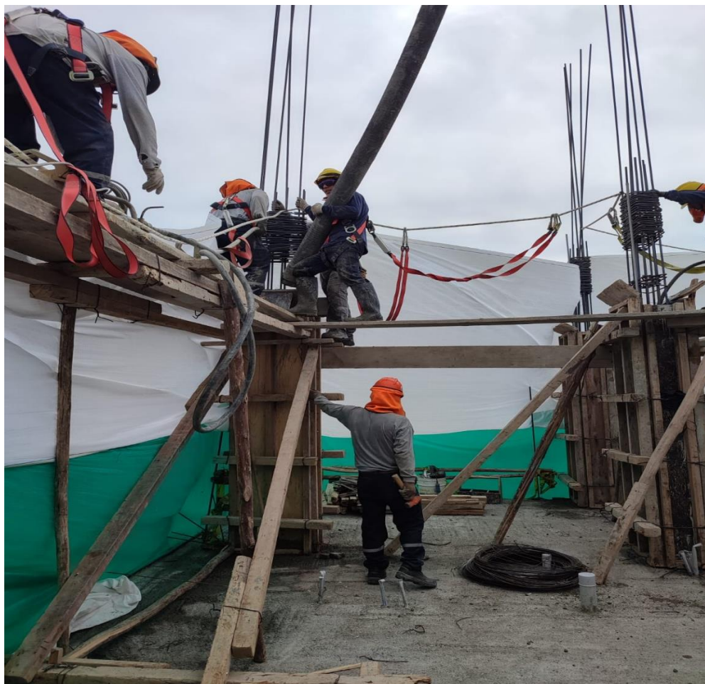
Figura 49. Implementación de arnés en trabajos de encofrado Tomada de empresa inmobiliaria
