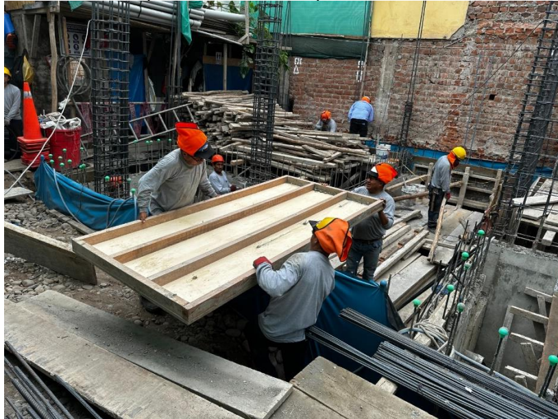
Preparación de materiales para el encofrado
