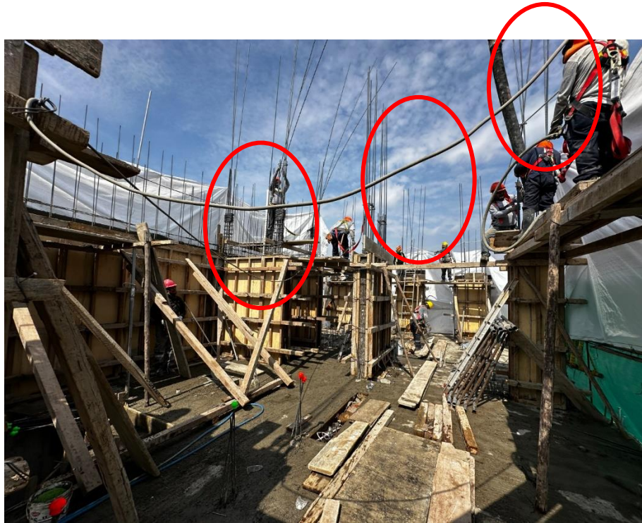
Figura 48. Implementación de arnés en trabajos de encofrado Tomada de empresa inmobiliaria
