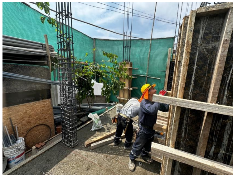
Encofrado de columnas
