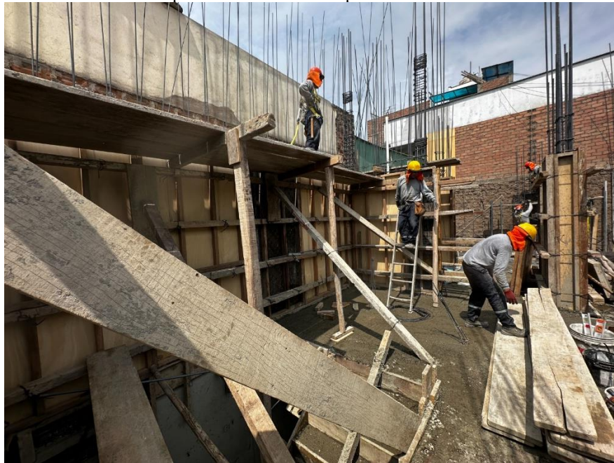
Preparación de materiales para el encofrado
