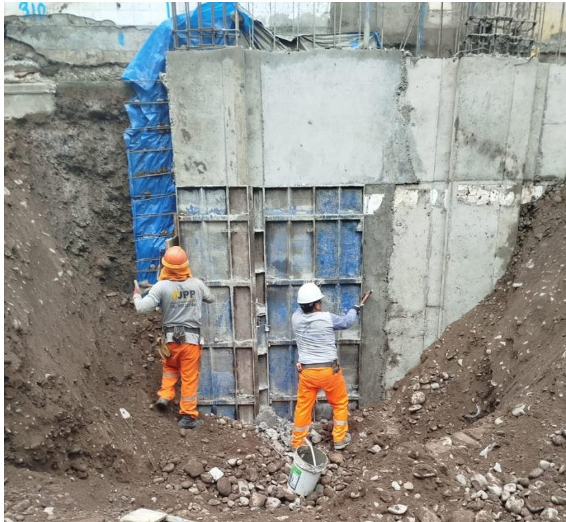
Verificación de encofrado
