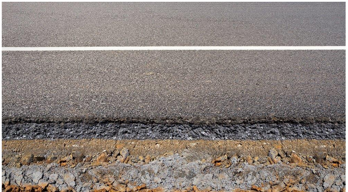
Ilustración 3 Pavimento flexible
