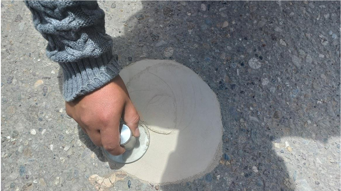
Ilustración 16 Esparcimiento de la arena sobre la superficie del pavimento
