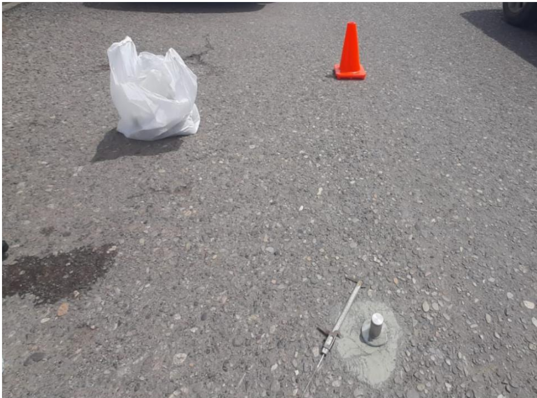
ANEXO 9 Esparcimiento de la arena sobre la superficie del pavimento
