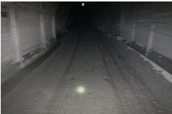
Figura 5. Vías resbalosas en interior mina producto de la filtración del agua del nivel freático.
