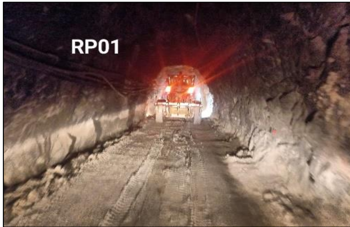
Figura 27. Mantenimiento de la vía - rampa 01 con la motoniveladora
