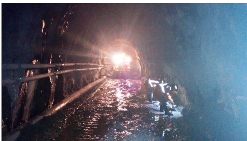
Figura 26. Mantenimiento de vías con equipo y personal en la limpieza de Cuneta
