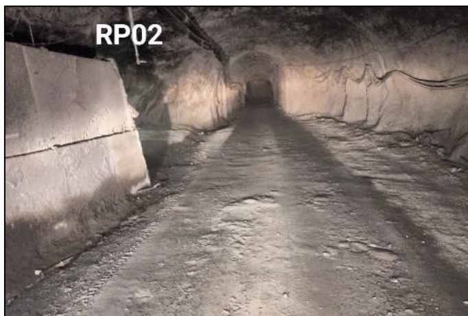
Figura 28. Mantenimiento de la vía - rampa 2 con la motoniveladora
