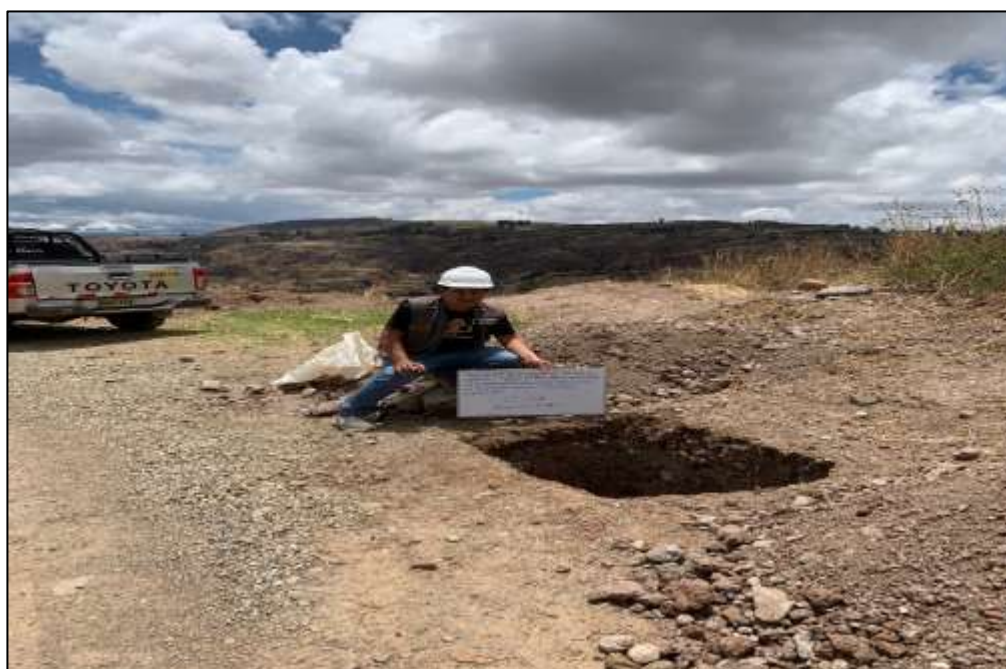
Fotografía 02: Ejecucion de las calicatas de evauacion.
