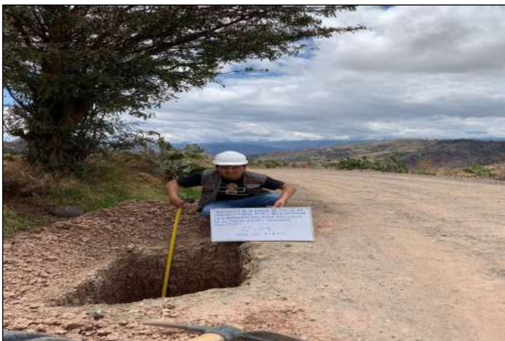
Fotografía 02: Determinacion de la profundidad de excavación
