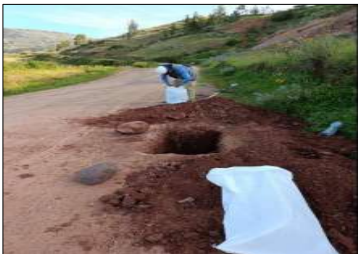
Figura 4. Excavacion de las calicatas de estudio
