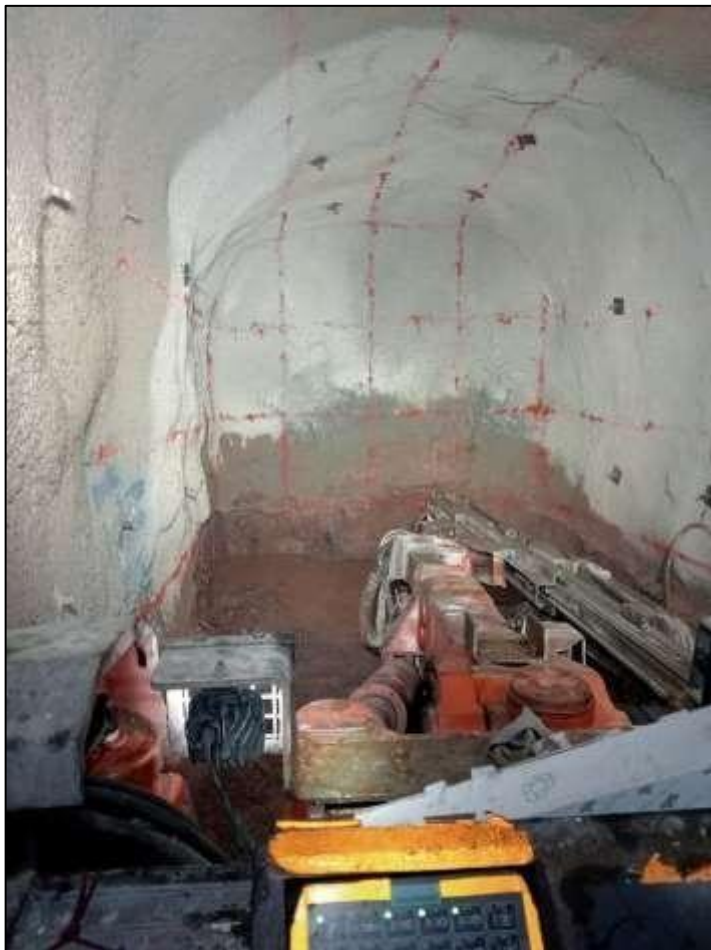
Figura 21. Pintado de proyecciones
