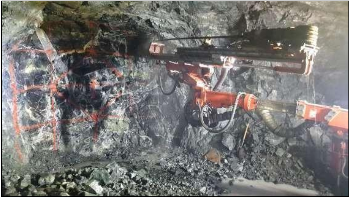
Fotografía 13. Perforación con Jumbo 14 pies - 1
