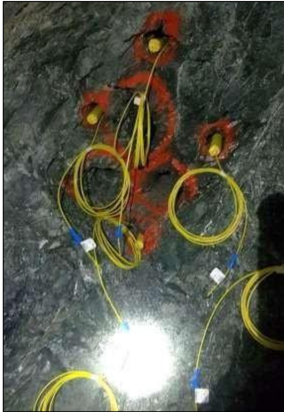
Fotografía 7. Carguío del arranque del frente
