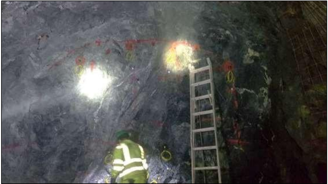
Fotografía 9. Distribución de la secuencia de disparos con faneles
