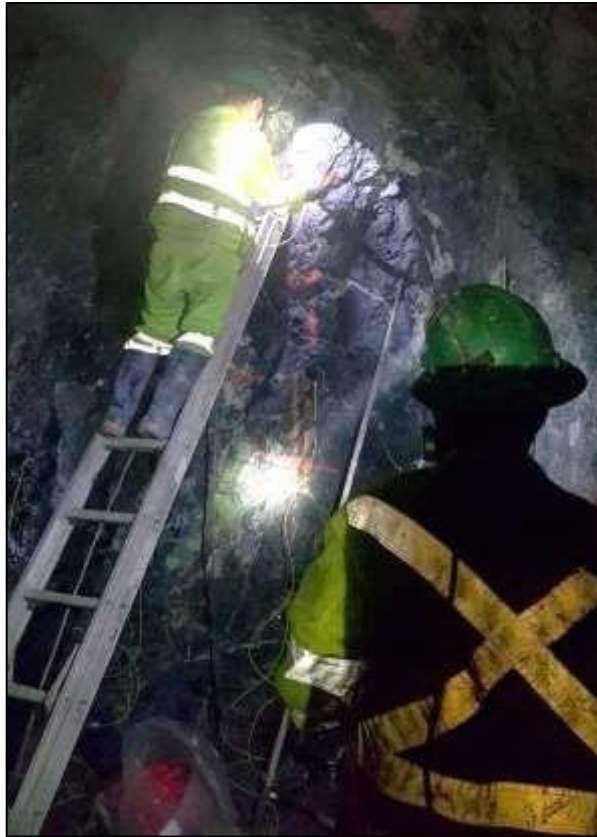
Fotografía 3. Carguío de explosivos en el frente de avance - 1
