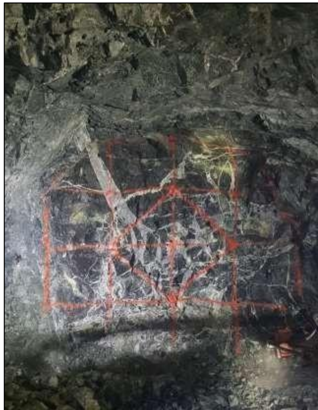
Fotografía 12. Seguimiento del marcado de la malla de perforación según la propuesta de mejora del estándar
