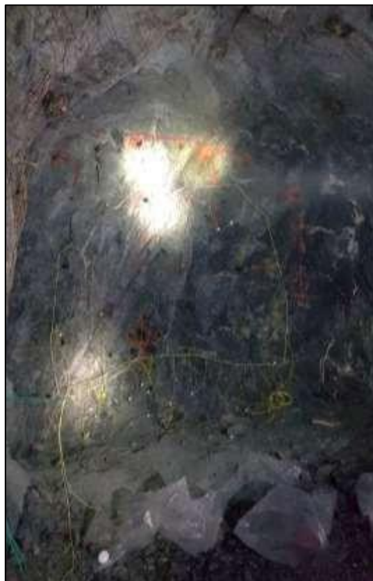
Fotografía 8. Frente cargado de explosivos
