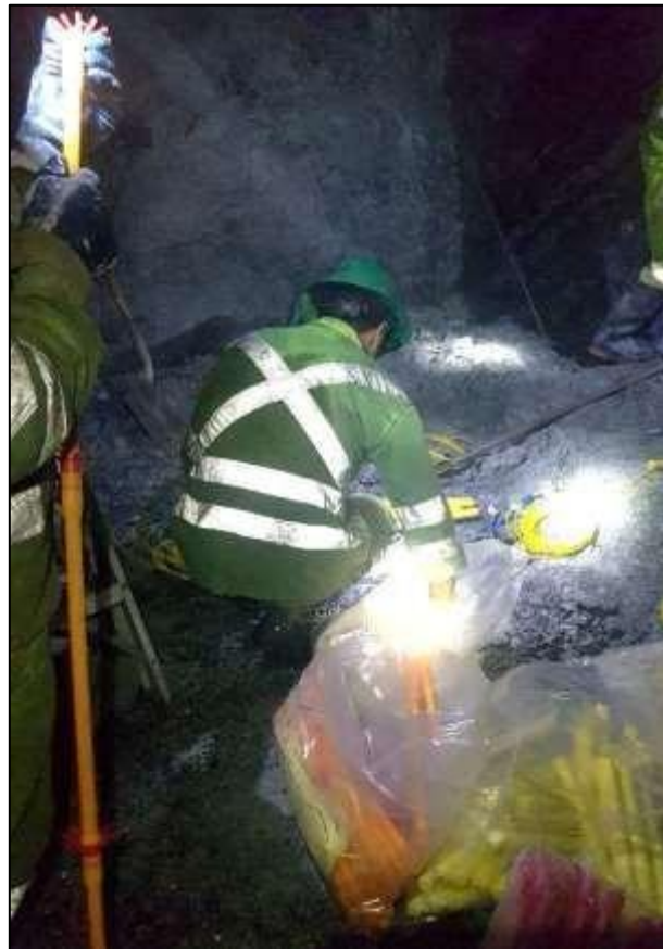
Fotografía 10. Preparación de los faneles con el cebo para la secuencia del disparo - 1
