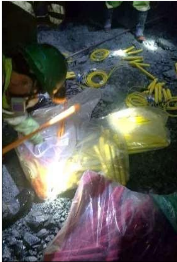
Fotografía 11. Preparación de los faneles con el cebo para la secuencia del disparo - 2
