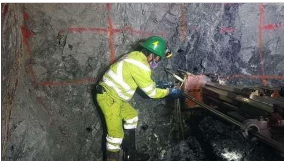
Figura 22. Uso de guiadores durante la perforación
