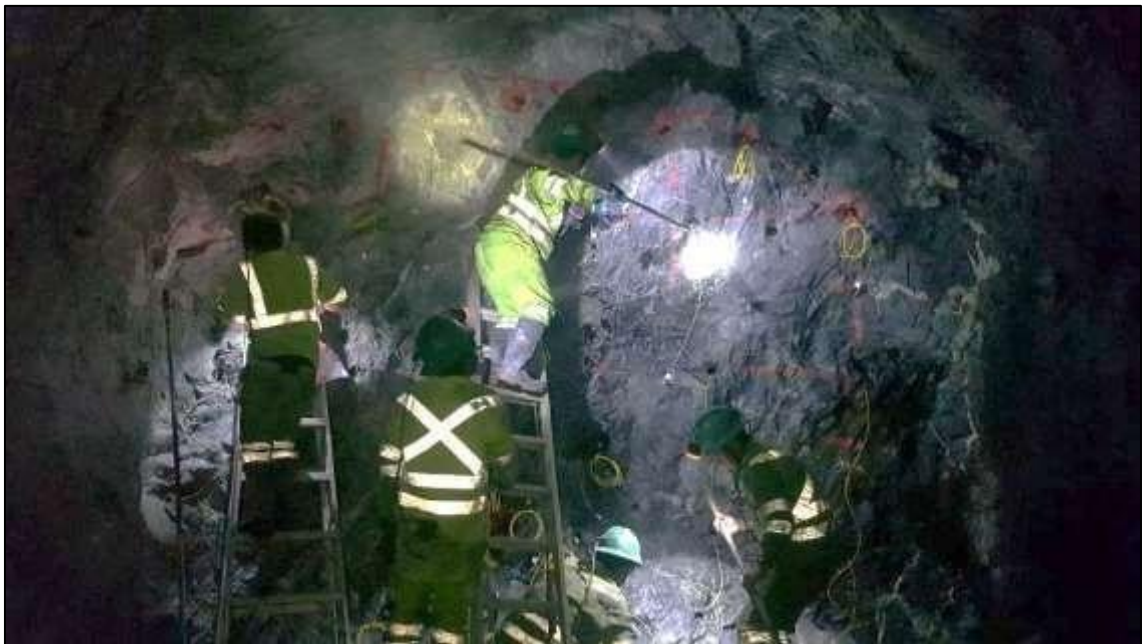
Fotografía 6. Carguío de explosivos en el frente de avance - 4
