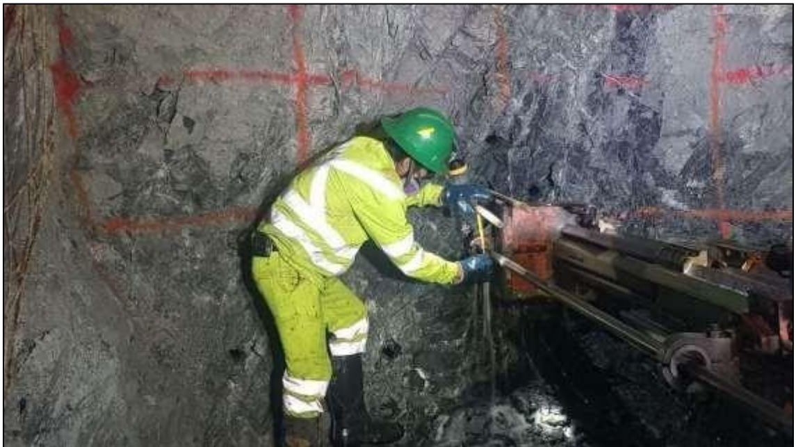
Fotografía 14. Perforación con Jumbo 14 pies - 2
