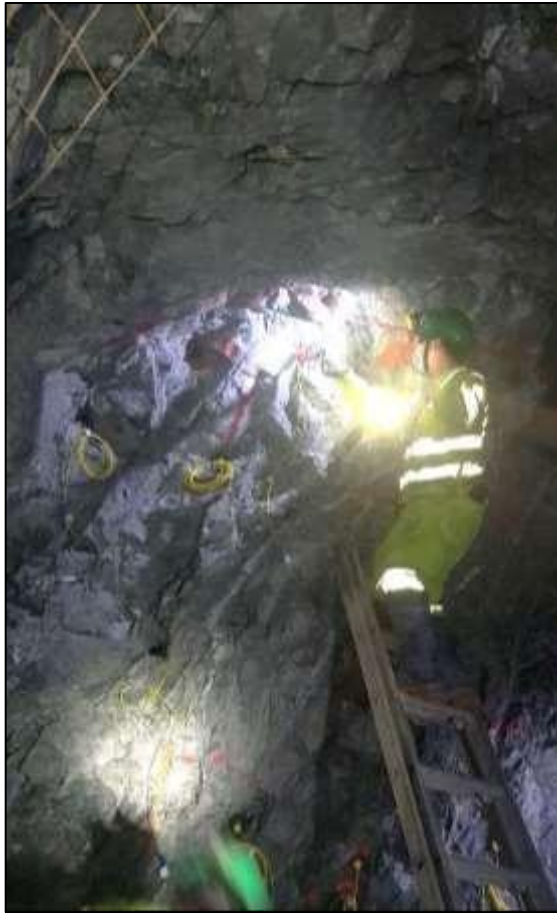
Fotografía 5. Carguío de explosivos en el frente de avance - 3
