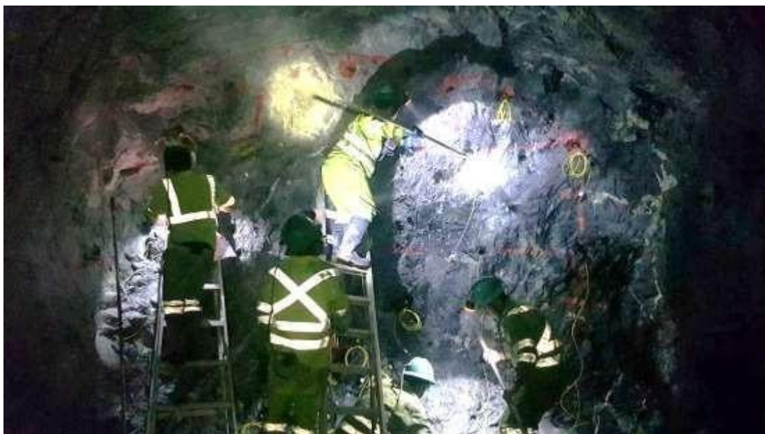
Figura 23. Supervisión del carguío de explosivos en el frente de avance
