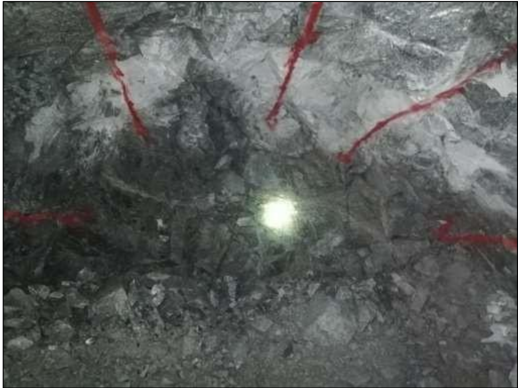
Figura 14. Resultado de una voladura controlada Rampa Liza NV 2860
