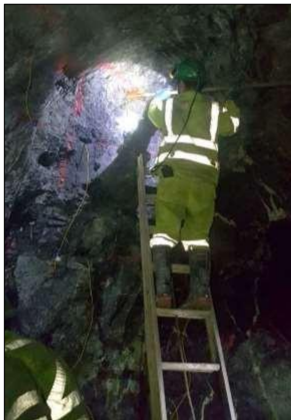
Fotografía 4. Carguío de explosivos en el frente de avance – 2
