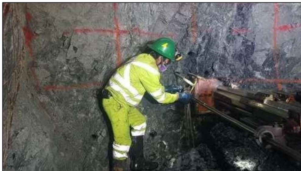
Figura 11. Seguimiento del paralelismo durante la perforación
