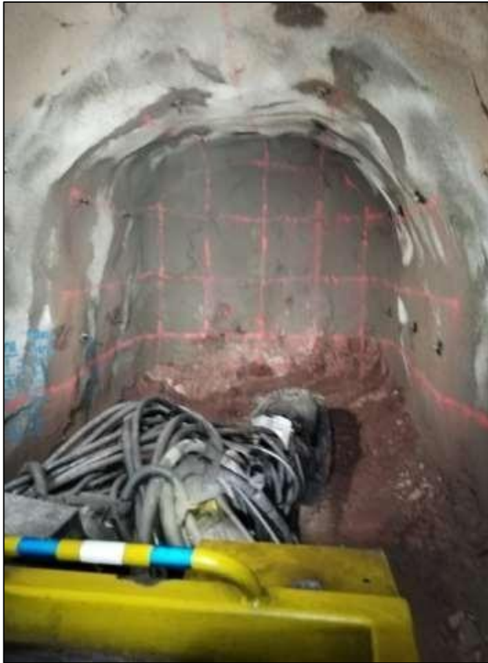
Figura 20. Seguimiento del marcado de la malla de perforación
