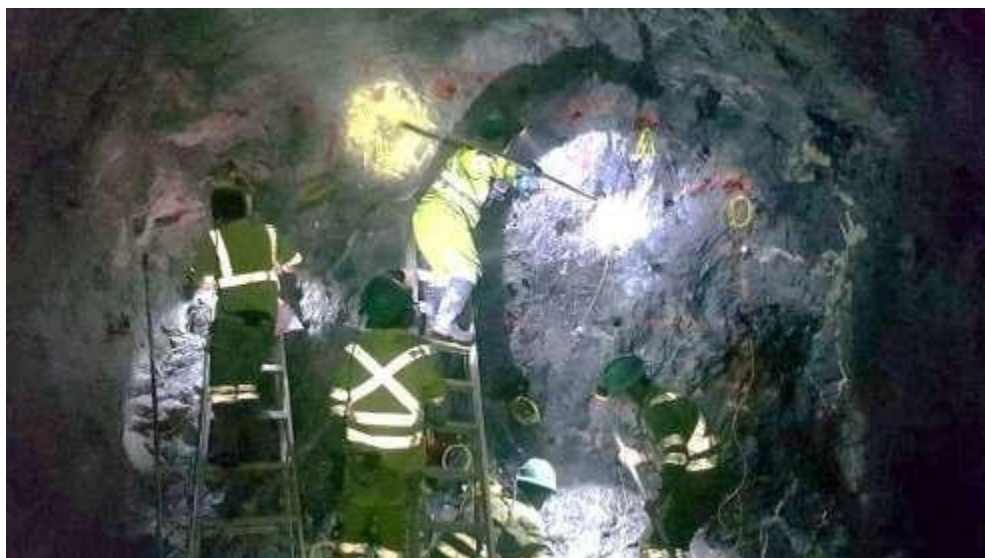
Figura 13. Carguío de la rampa Liza NV2860
