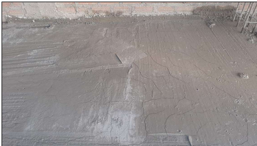
Figura 3. Fisuras en la estructura de losa aligerada, Deficiencia en la combinación de agregados en el diseño del concreto bombeable. Tomada en un proyecto de vivienda unifamiliar en Huancayo, Huancayo, Junín, 2022.
