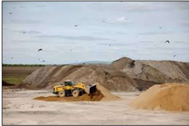
Figura 28. Muestra de agregados 1.
