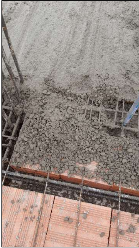
Figura 3. Fisuras en la estructura de losa aligerada, Deficiencia en la combinación de agregados en el diseño del concreto bombeable. Tomada en un proyecto de vivienda unifamiliar en Huancayo, Huancayo, Junín, 2022.
