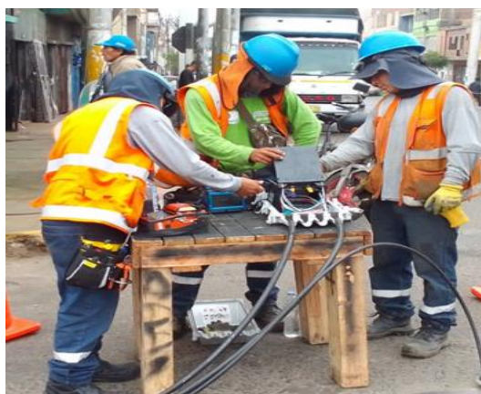
Figura 38. Instalación caja empalme
