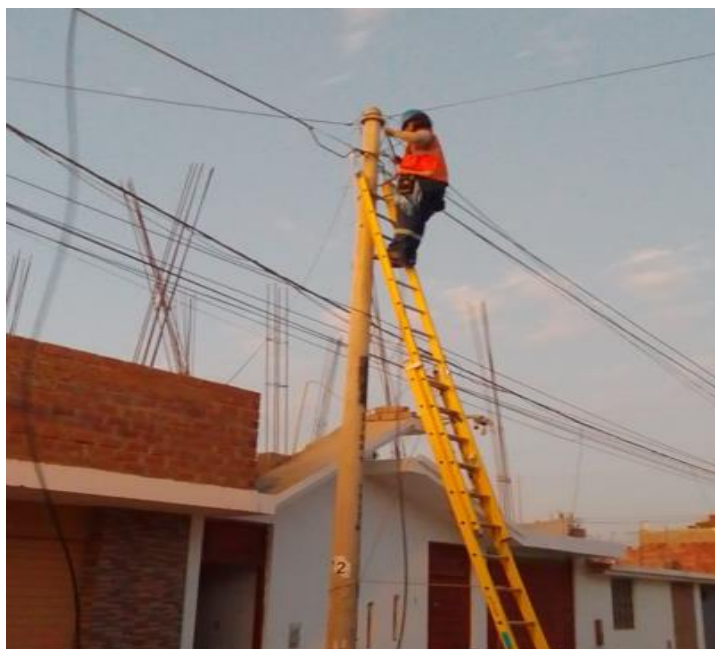
Figura 31. Colocación de ferrería aéreo
