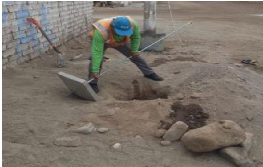
Figura 26. Instalación ancla retención de poste
