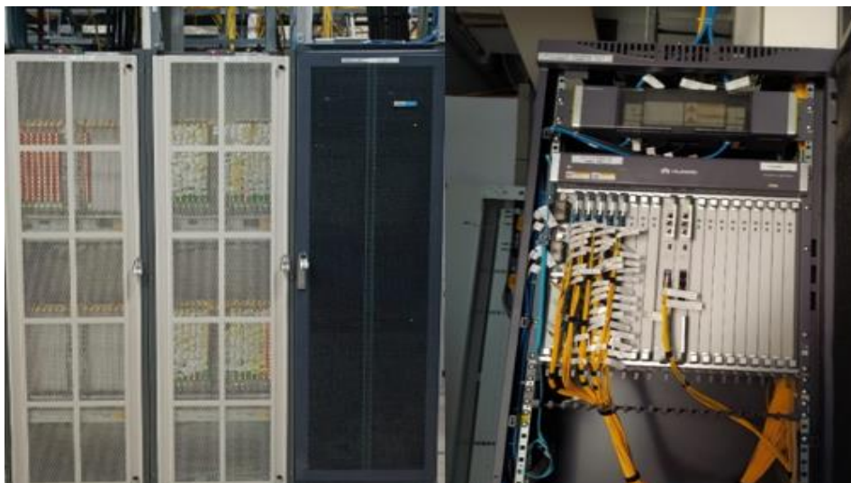
Figura 33. Instalación OLT
