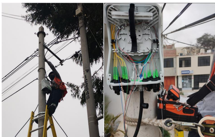
Figura 39. Instalación CTO
