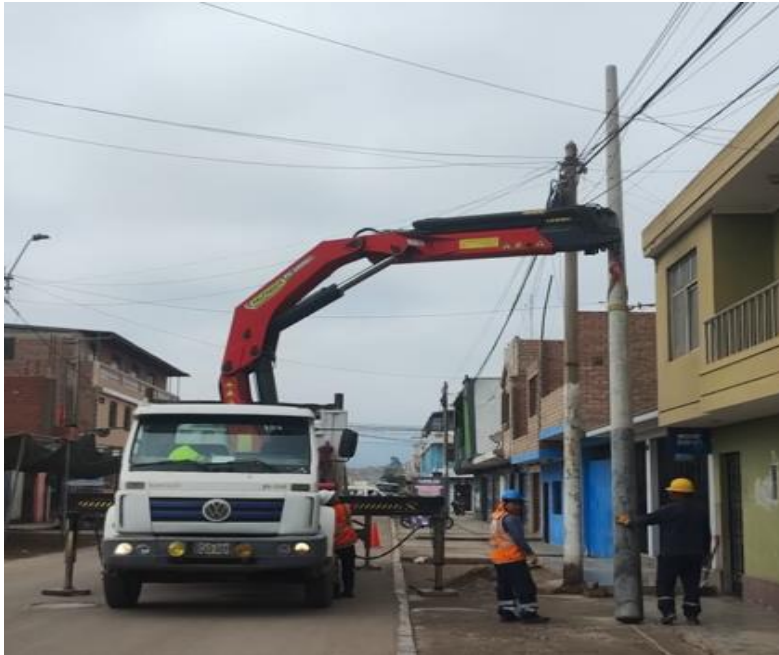
Figura 28. Instalación de poste
