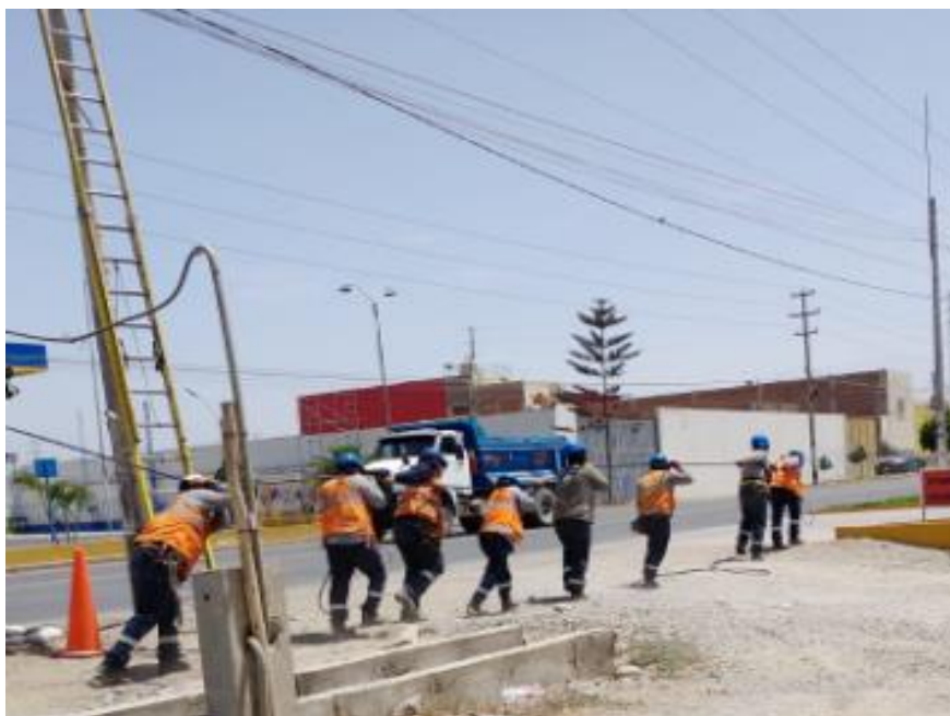
Figura 30. Tendido aéreo
