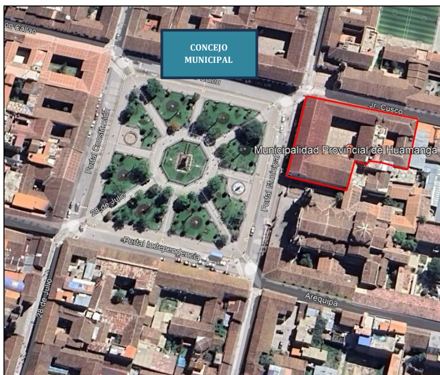
Figura 1. Ubicación de la Municipalidad Provincial de Huamanga.
