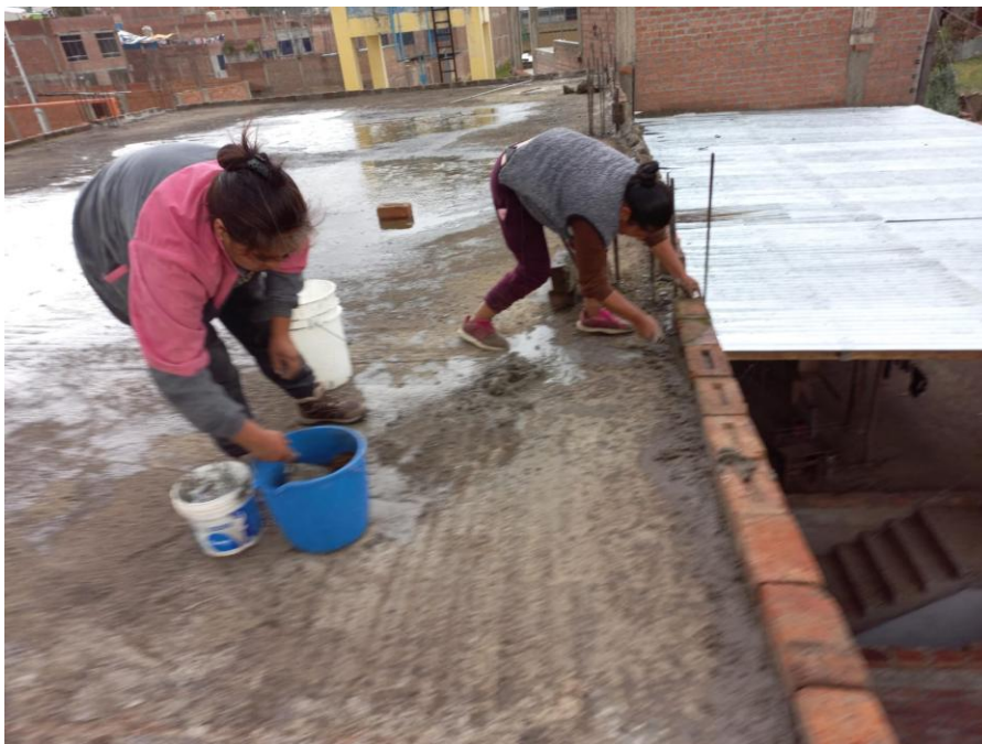
Figura 18. Estado del techo
