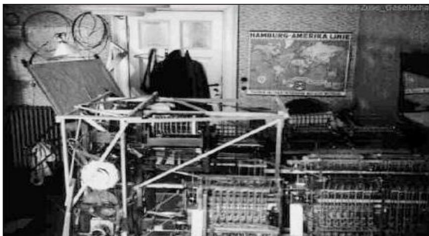
Figura N° 1 : Primera computadora digital programable de propósito general
