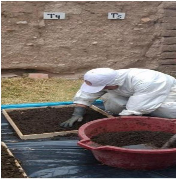
Fotografía N° 41. Armado de la primera capa 30 cm de material preparado.
