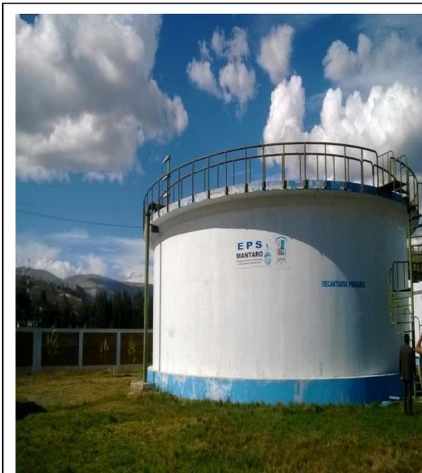
Fotografía N° 3. Decantador primario.
