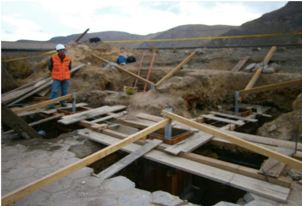
**FOTO 7:** alineación de los 4 anclajes de la torre de la transmisión eléctrica
