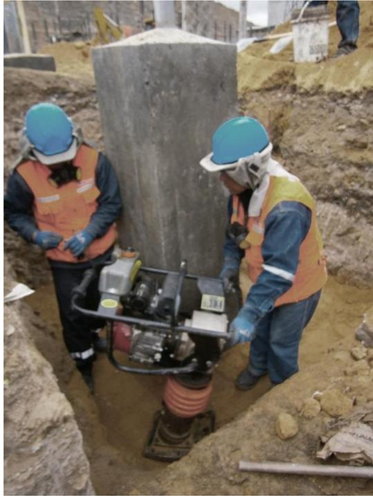
**FOTO 10:** relleno y compactado de cimentación (Fuente: Elaboración propia).
