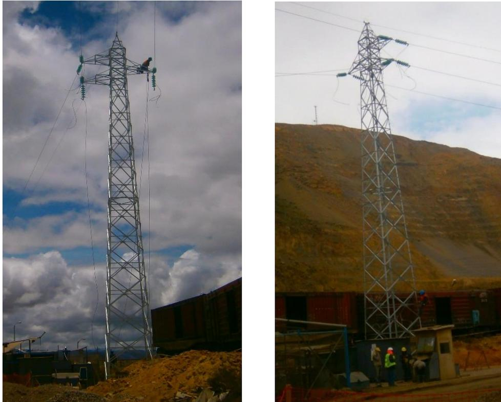
Figura 2. Torres de suspensión de transmisión eléctrica
