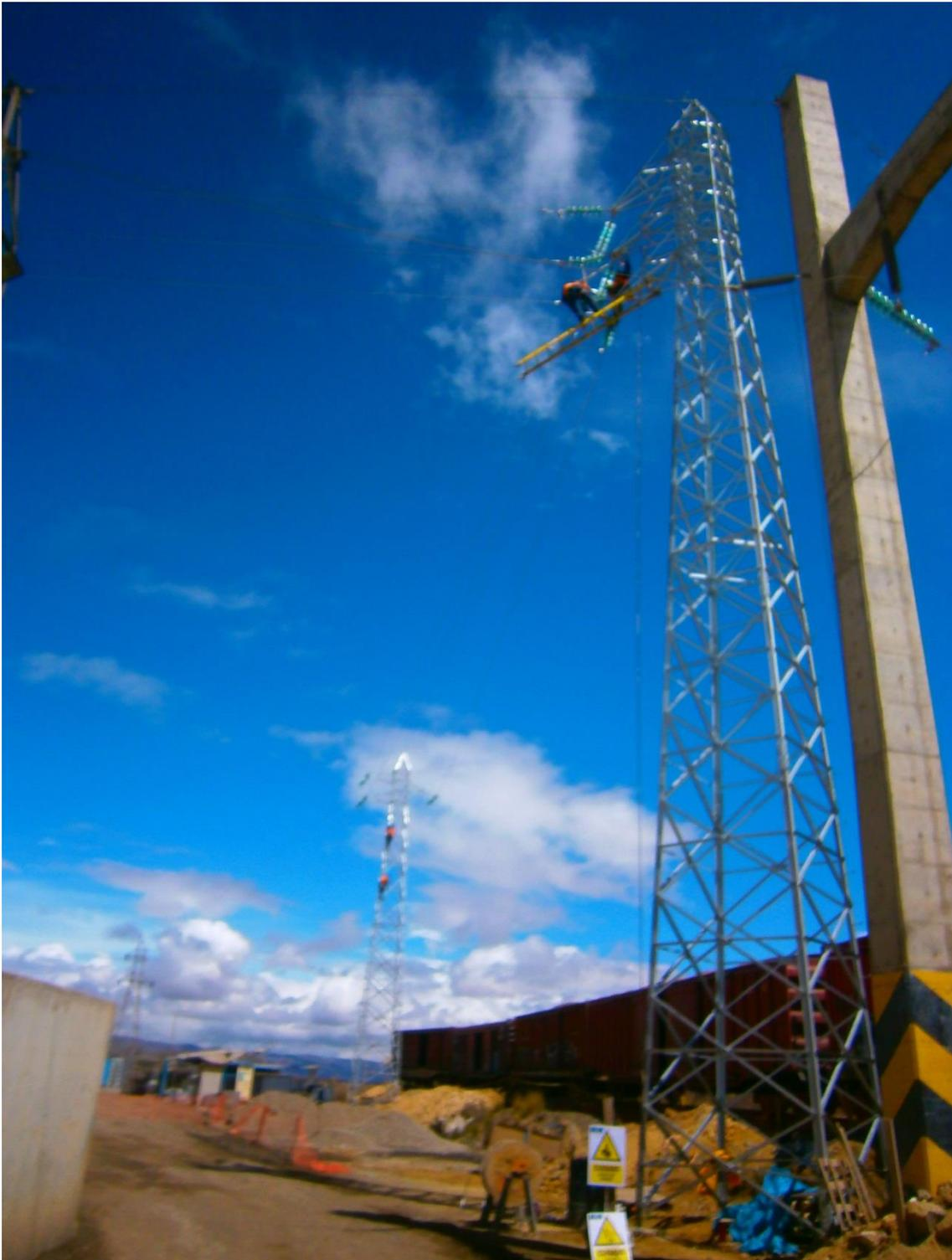
**FOTO 12:** Tendido de cable de guarda y cable de tensión
