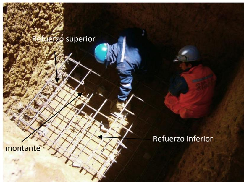
**FOTO 3:** Armado del refuerzo superior e inferior de la cimentación (Fuente: Elaboración propia).
