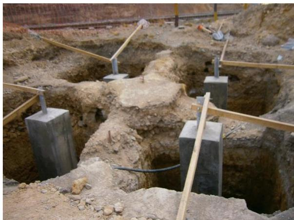
**FOTO 9:** Desencofrado de pedestal
