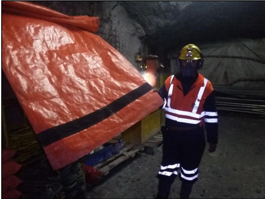
MANGA DE VENTILACIÓN
