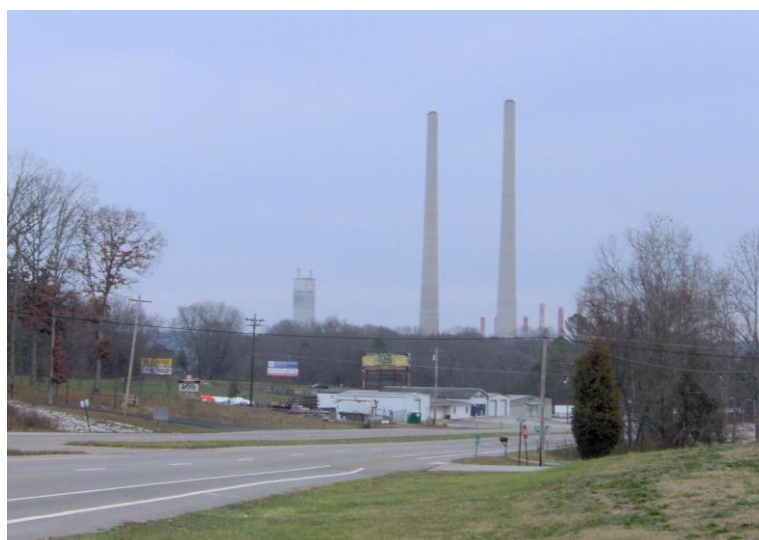
Figura N° 06. Desastre residual en Kingston (2008). Peores desastres mano
