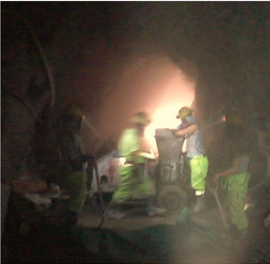
**Figura 12: Mezclado del Shotcrete en el Nv.6 - XC 750W en Aliva**
