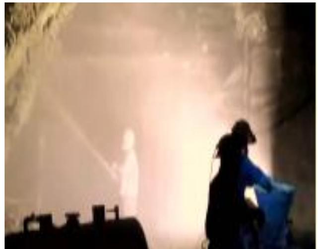
**Figura 15: Lanzado de shotcrete en el Nv.6 - XC 750W**
