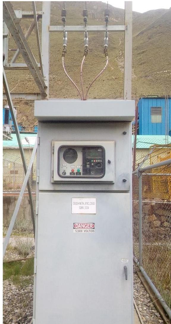
**Figura N° 218: Disposición del Interruptor de Potencia de Minera IRL**
