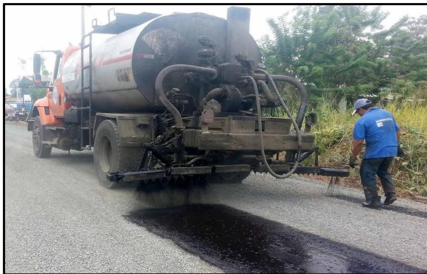
**Figura 1. Imprimación asfáltica.**
