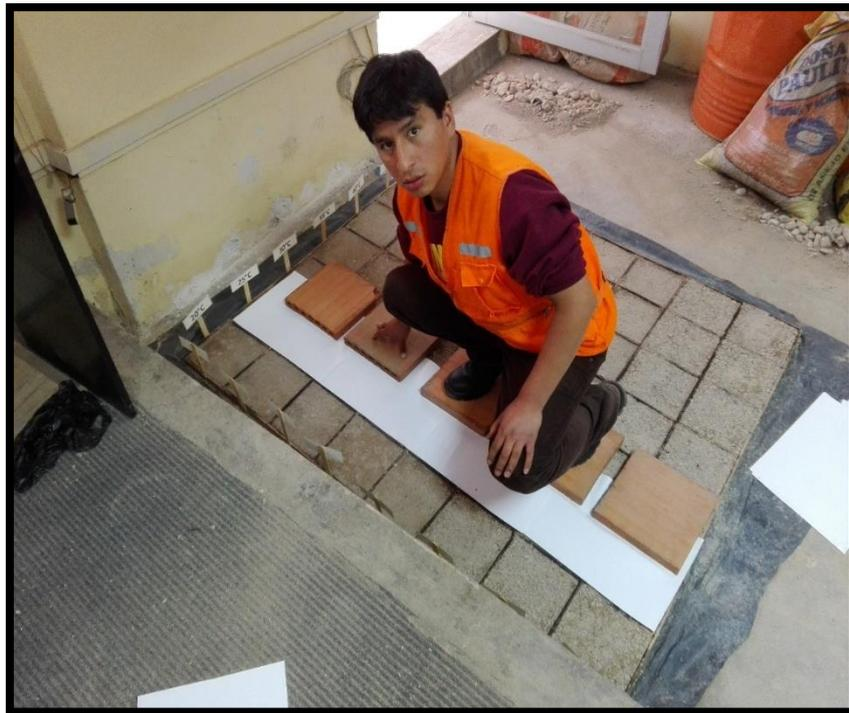
Foto 20: Preparación del molde para aplicar la emulsión asfáltica.
