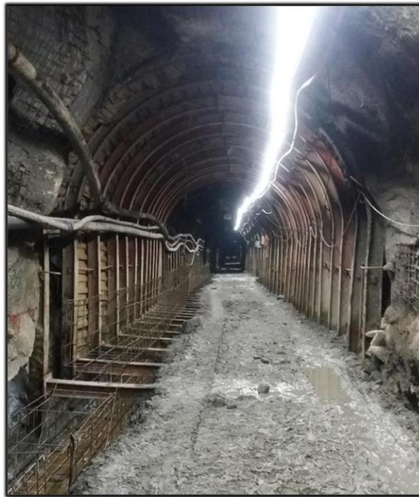
*Figura N° 11: Sostenimiento con cimbras metálicas
