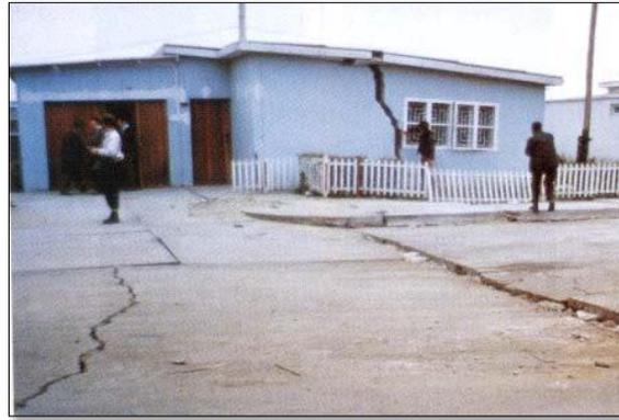
Figura 2: Asentamiento de la cimentación por efectos de licuefacción de suelos en Chimbote, terremoto 1970.
