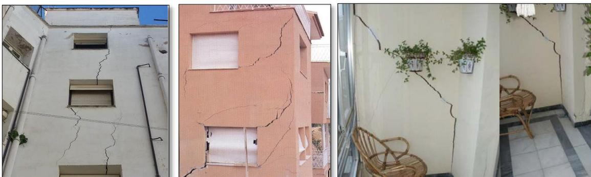
Figura 4: Fisuras a causa de asentamiento en edificaciones.
