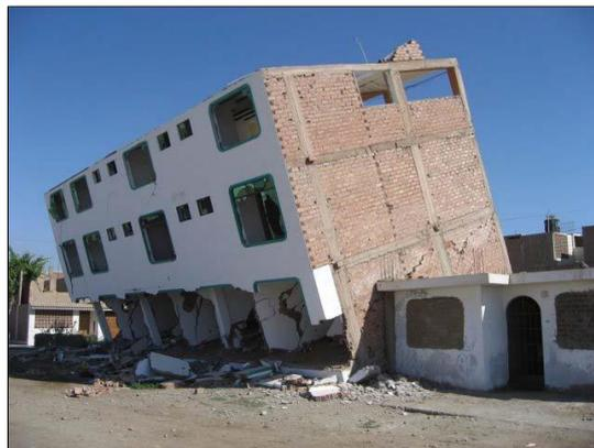
Figura 3: Desplazamiento de la losa de cimentación de una edificación en Pisco-15/08/2007.
