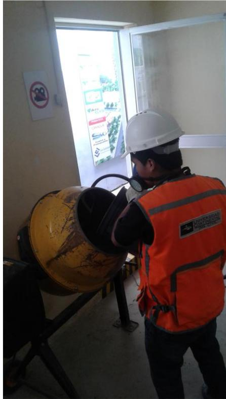
Foto 13: Vaciado de la emulsión asfáltica CSS-1h.
