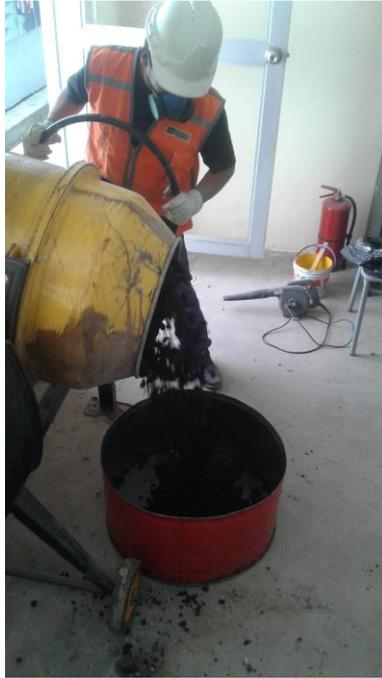
Foto 15: Después de un mezclado homogéneo, se vierte el material en un recipiente para posteriormente ser ensayado.
