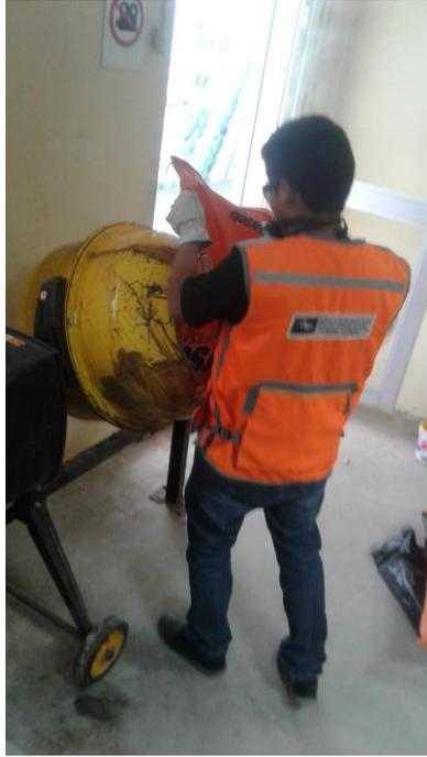
Foto 11: Vaciado del material al trompito para ser mezclado y encontrar una mezcla homogénea.
