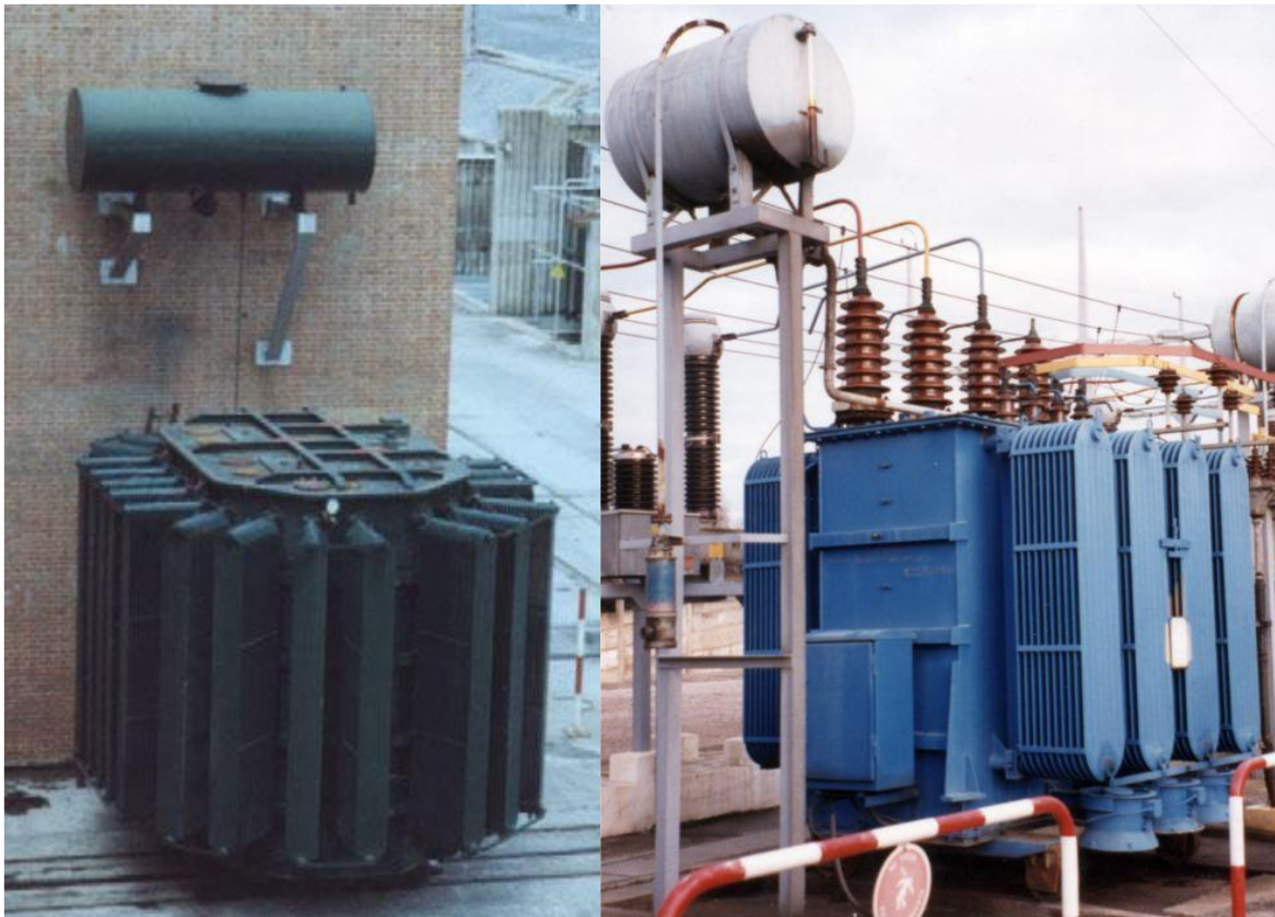
Figura 6a, 6b: Transformadores en baño de aceite:
