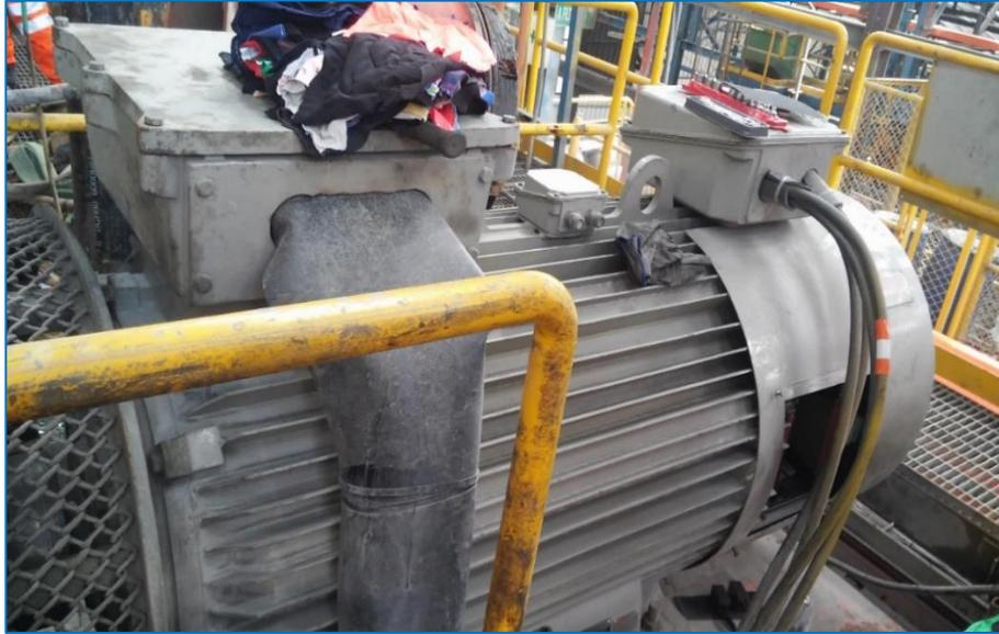
Figura 3: Motor eléctrico acoplado al molino de bolas
