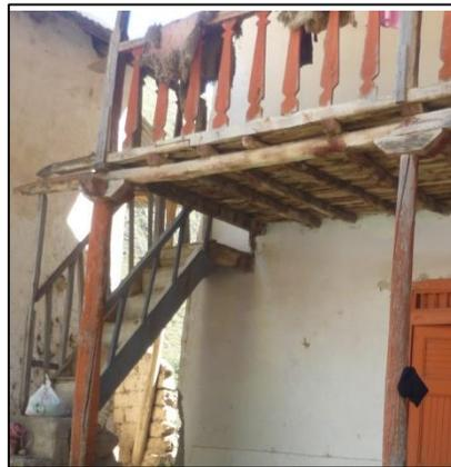
**IMAGEN 161:** VIGAS Y VIGETAS DE MADERA – DISTRITO DE IZCUCHACA
