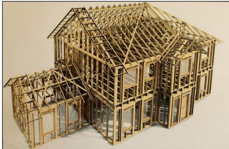
**IMAGEN 173:** CONSTRUCCION SISTEMA DE MADERA
