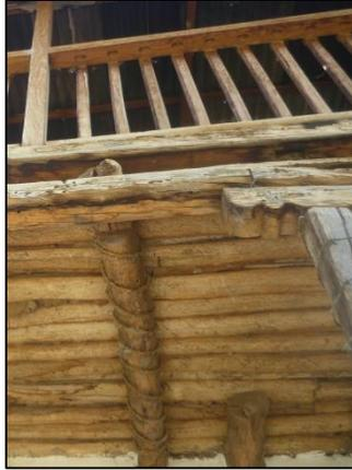
**IMAGEN 162:** VIGAS Y VIGETAS DE MADERA – DISTRITO DE IZCUCHACA
