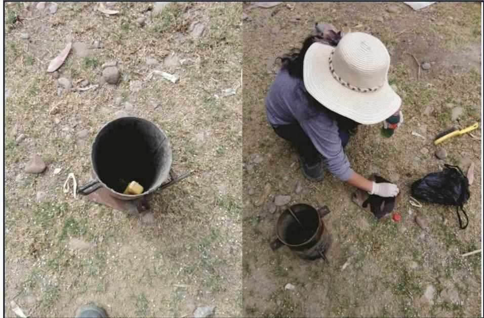
*Figura 22: Aceitado de encofrado.
