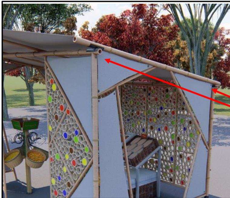
Unión perpendicular con disco y canal de acero
