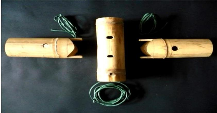
Figura 22: Corte boca de pez (Unión en cruz; variante 1; 2 bocas de pez con orejas y bejucos)
