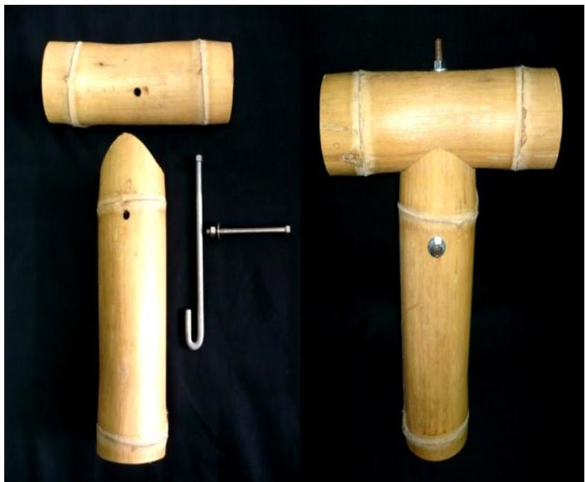
Figura 23: Corte boca de pez (apoyo de vigas- uso de perno con gancho y anclaje)
