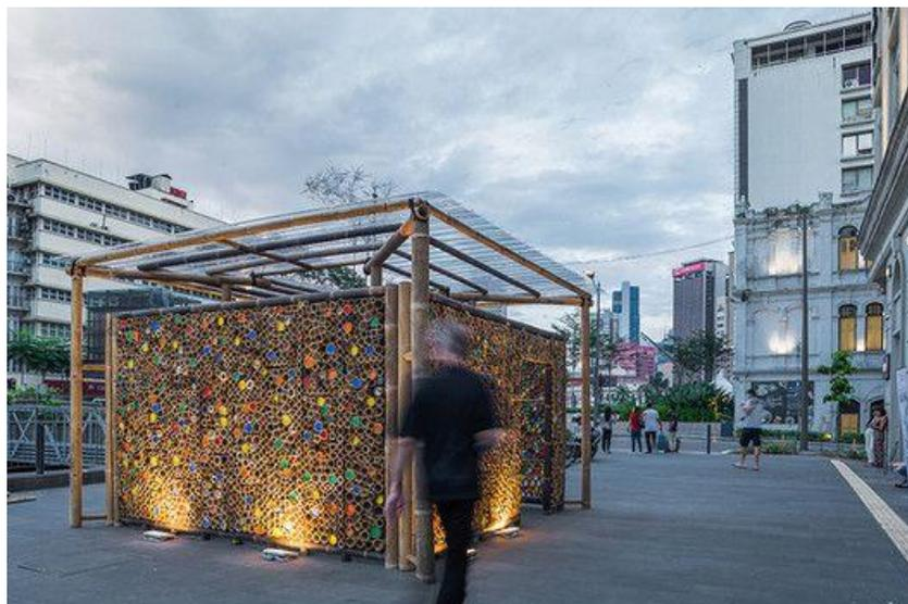
Figura 4: Muros permeables de bambú.
