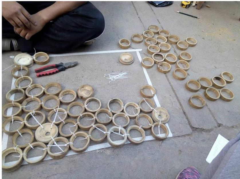
Figura 86: Construcción del panel hecho de anillos de bambú.
