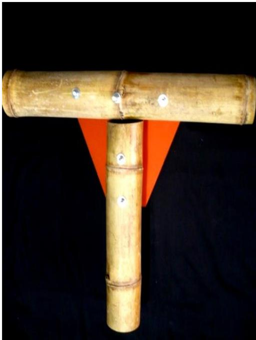
Figura 40: Uniones a tope (Uso de placas, tuercas y pernos de acero).
