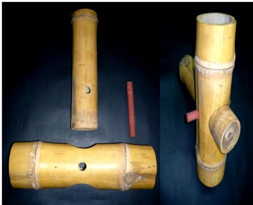
Figura 35: Unión en cruz (Pies derechos y vigas, bambú de menor diámetro).
