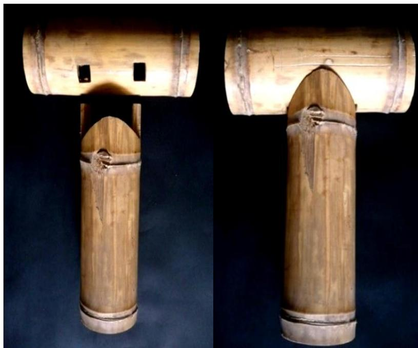
Figura 18: Corte boca de pez (Variante con dos orejas o lenguas)
