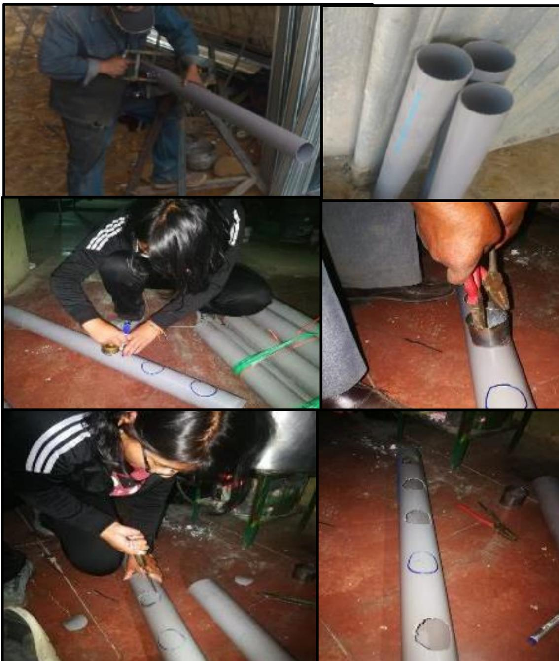
Fotografía 16: Cortado y Perforado de los Tubos.
