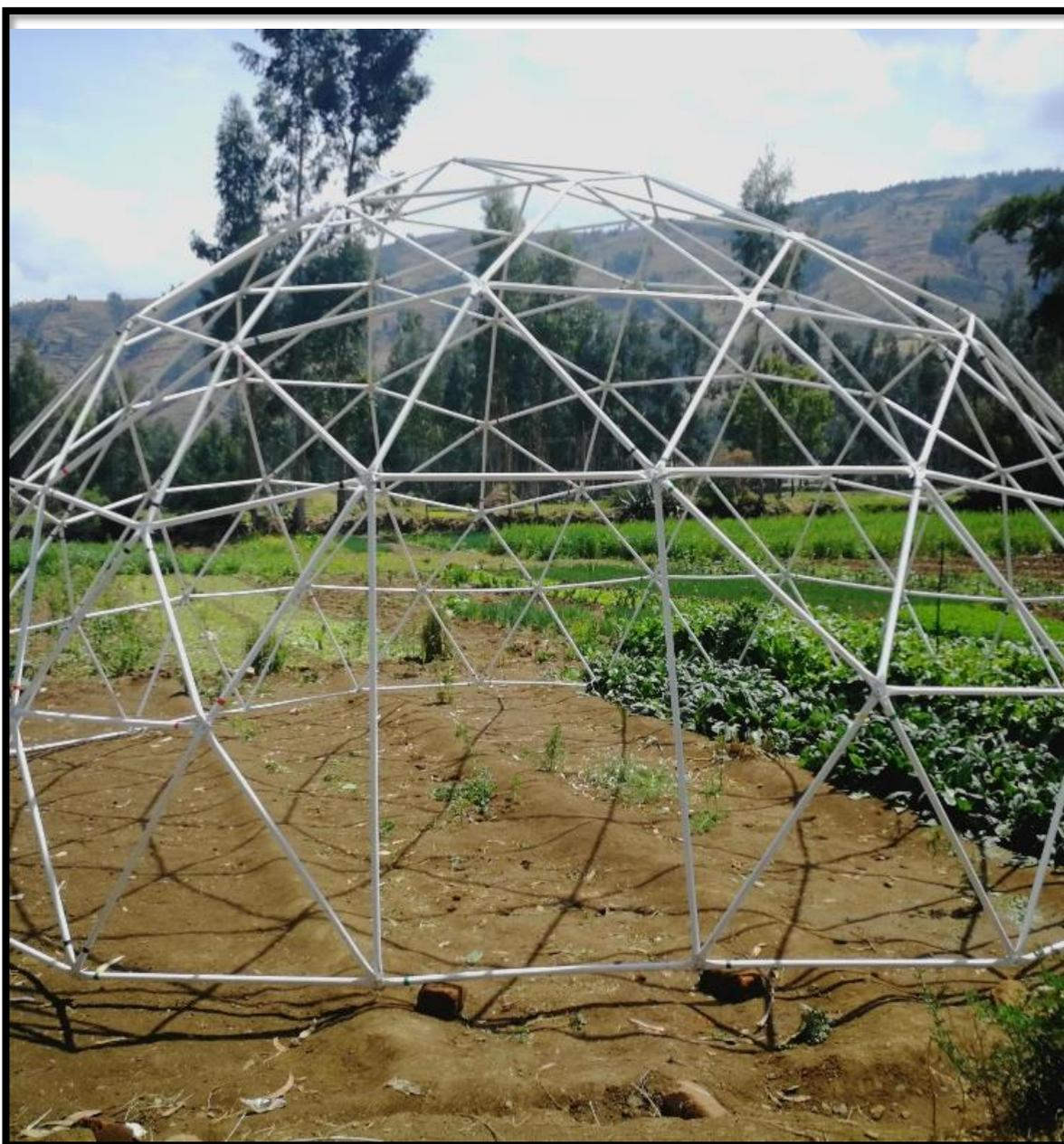
*Fotografía 13: Estructura Domo frecuencia 4*
