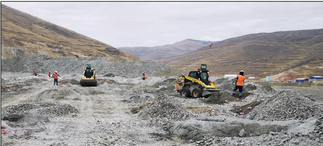
Figura anexo 4: Tapado mecanizado de taladros
