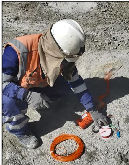
Figura anexo 2: Primado de taladros con detonadores electrónicos
