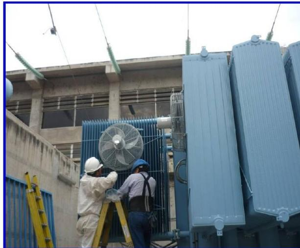
Foto 02 : Montaje de ventiladores del Transformador.
