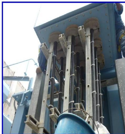
Foto 12 : Conexión de cables de BT en cajuela
