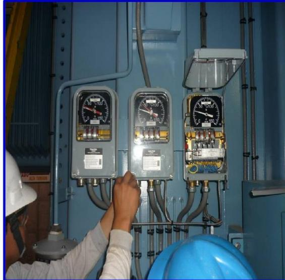
Foto 11 : Puebas de protecciones alarma , disparo con respecto a las temperaturas ( Aceite y devanados BT,AT)
