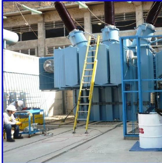
Foto 09 : Ejecución de pruebas eléctricas finales al transf.
