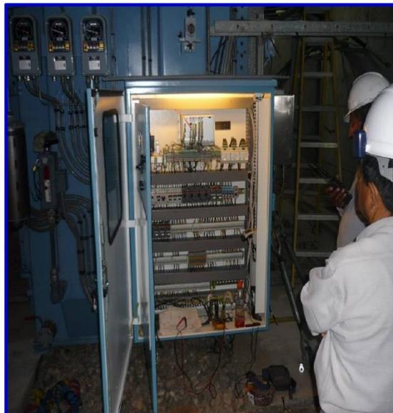
Foto 10 : Pruebas funcionales de las protecciones del transformador
