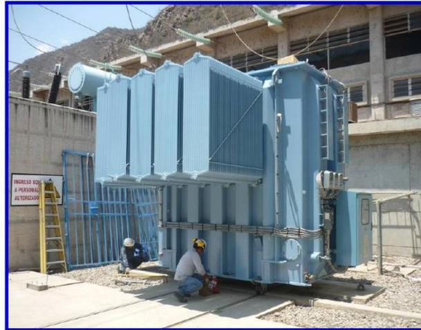
Foto 01 : Transformador en la celda de operación con los radiadores montados.
