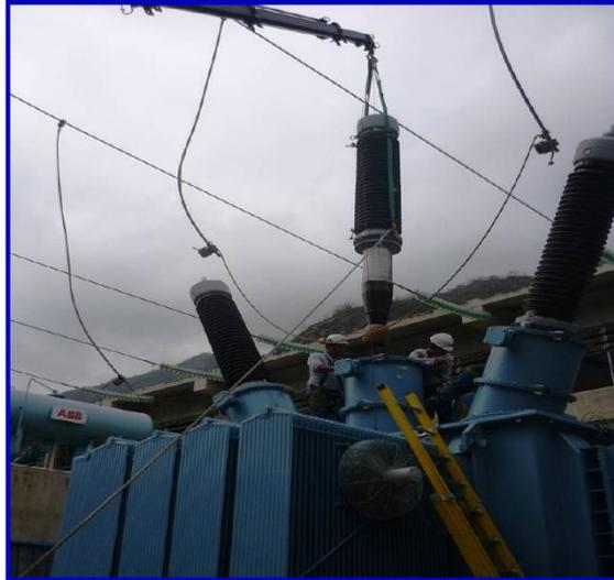
Foto 03 : Montaje de los Bushing AT.
